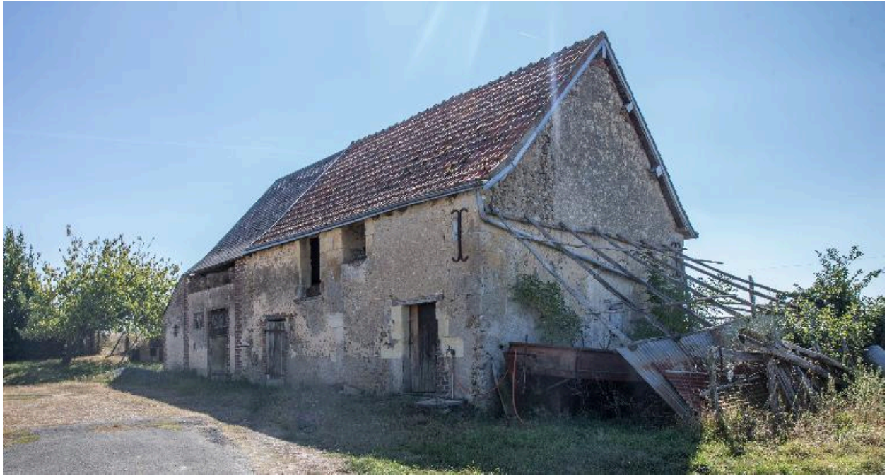
Grange-étable à fenil, vue de volume.
