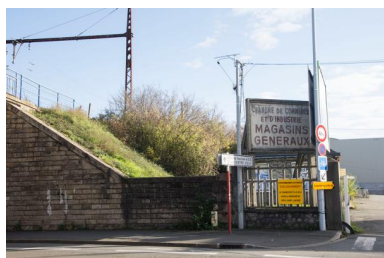
Vue de l'entrée des magasins généraux avec la plaque d'identification. Phot. Bruno Rousseau IVR52_20207201147NUCA
