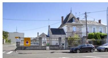
Vue de l'entrée des magasins généraux. Phot. Pierre-Bernard Fourny IVR52_20197202206NUCA
