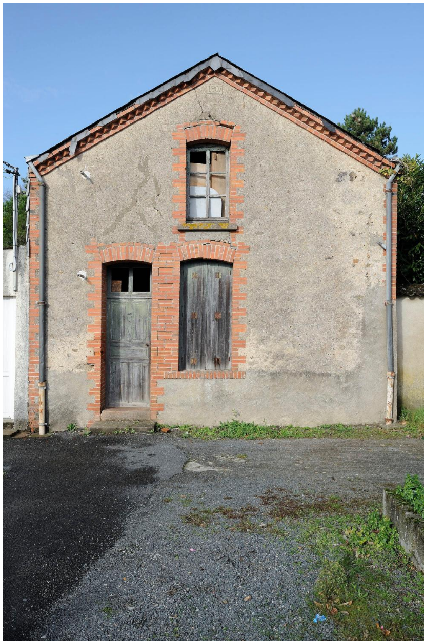
Maison du concierge depuis l'impasse des Aires.
