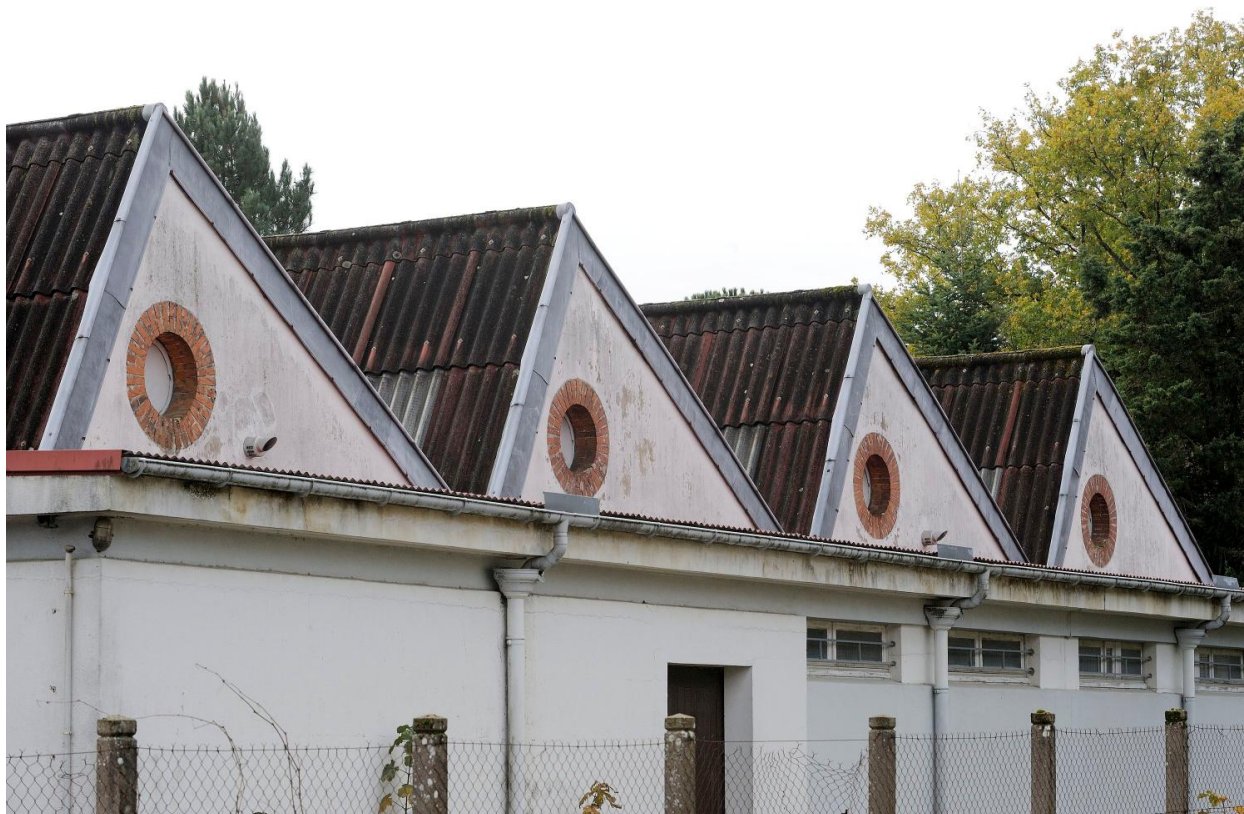
Détail des sheds, vue depuis la rue Augustin Vincent.
