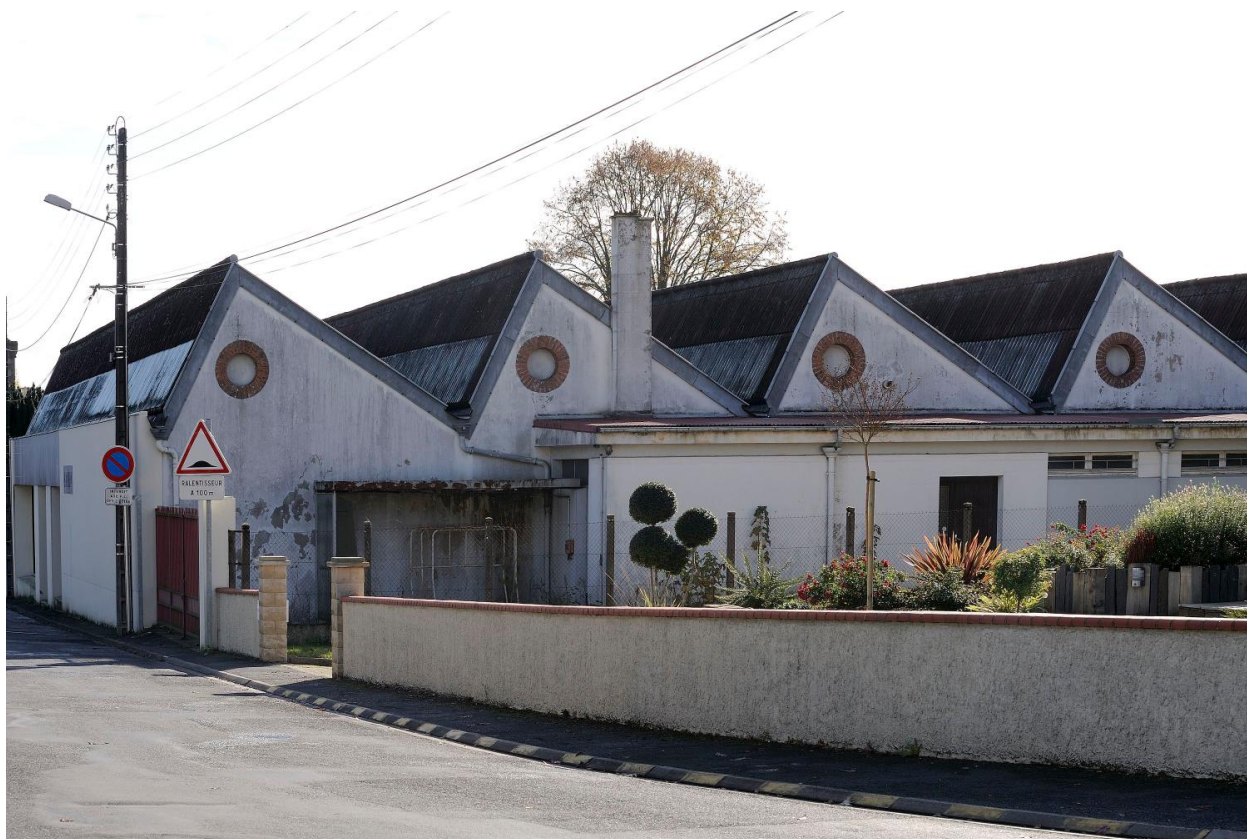
Vue générale de l'usine.
