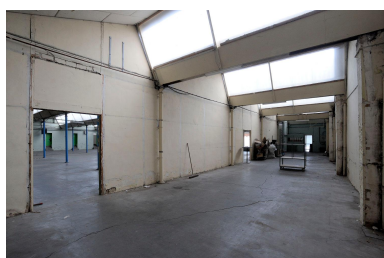
Magasin situé côté Est. Phot. Bruno Rousseau IVR52_20104902060NUCA
