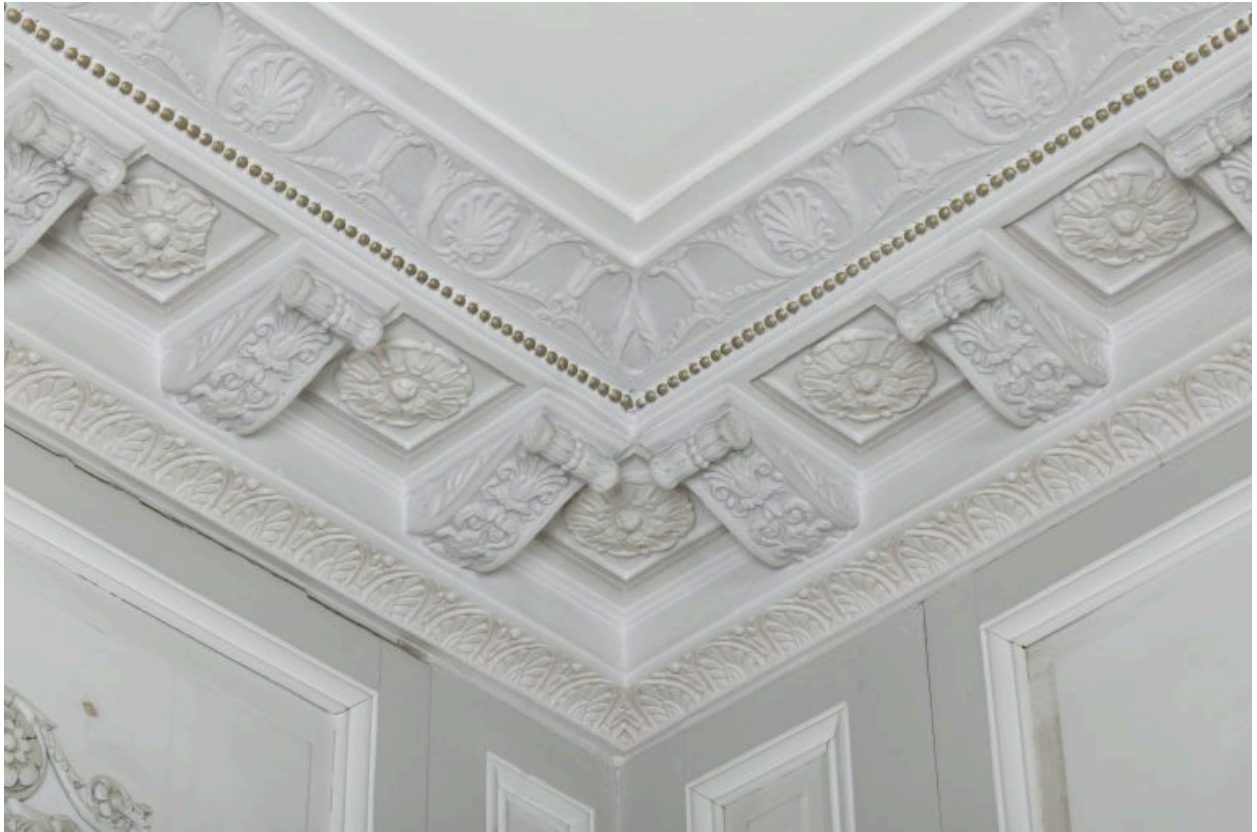
Cabinet du maire, détail du plafond.
