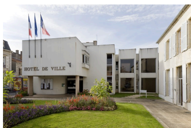
Partie moderne de l'hôtel de ville. Phot. Patrice Giraud IVR52_20108500448NUCA
