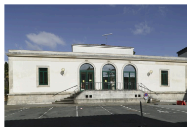
Salle des fêtes construite par Marcel Manceau vers 1950 (anciennes justice de paix et salle des fêtes). Cf. IM 4. Phot. Patrice Giraud IVR52_20078500051NUCA
