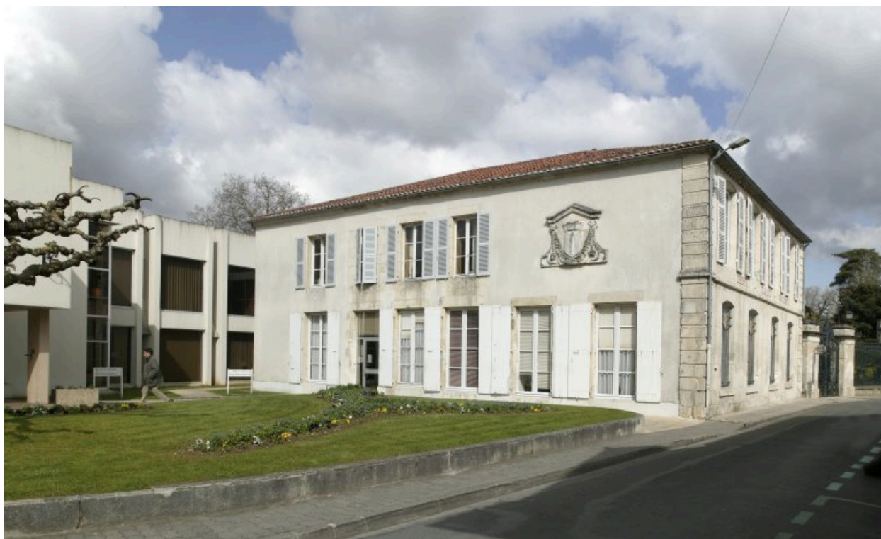
Vue prise du sud montrant la façade arrière de la maison Dumaine et, à gauche, la partie moderne de l'hôtel de ville.
