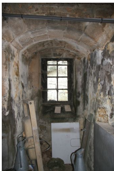
Ancienne cuisine semi troglodytique proche la cour des offices. Phot. Jean-Baptiste Darrasse IVR52_20057203471NUCA
