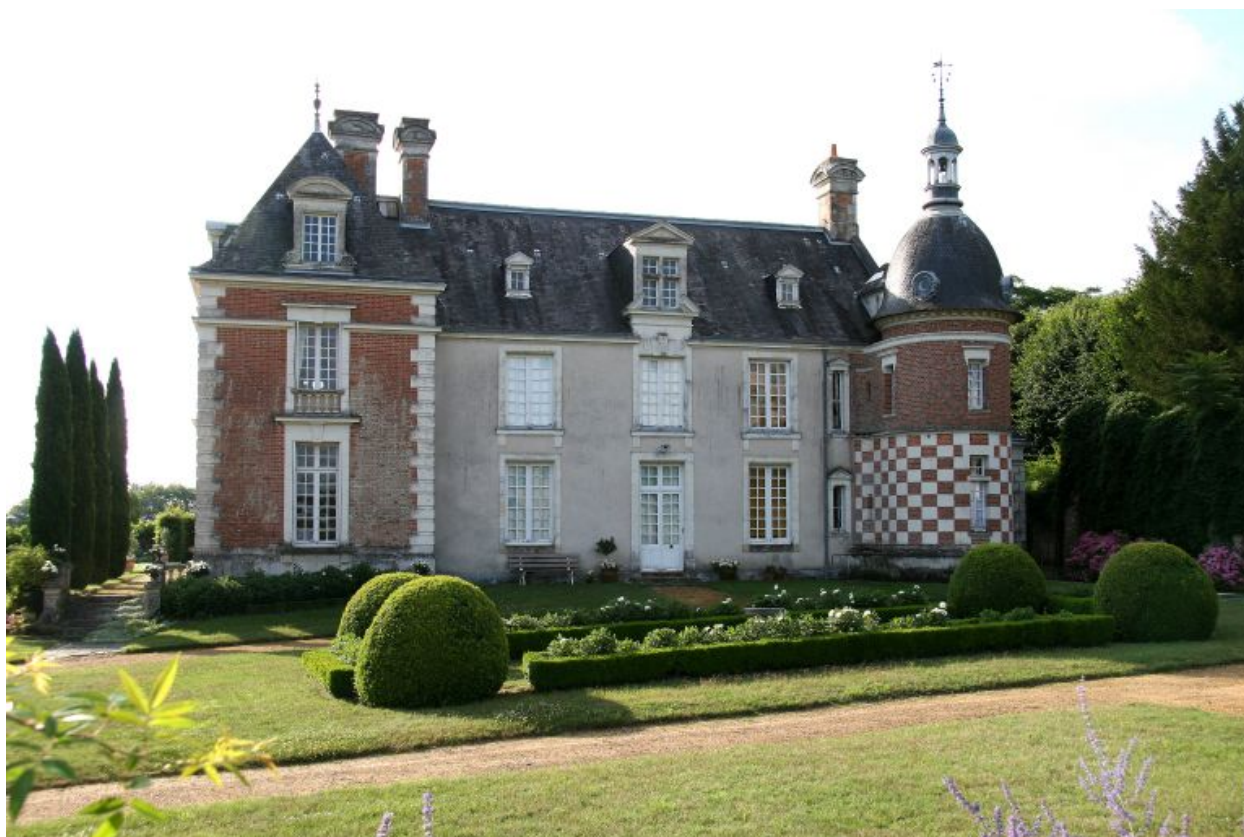
Le logis : façade antérieure.
