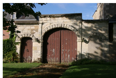
Le portail d'entrée et la porte piétonne. Phot. Jean-Baptiste Darrasse IVR52_20057203044NUCA
