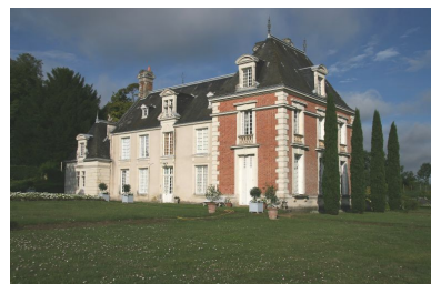
Le logis : façade postérieure. Phot. Jean-Baptiste Darrasse IVR52_20057203047NUCA
