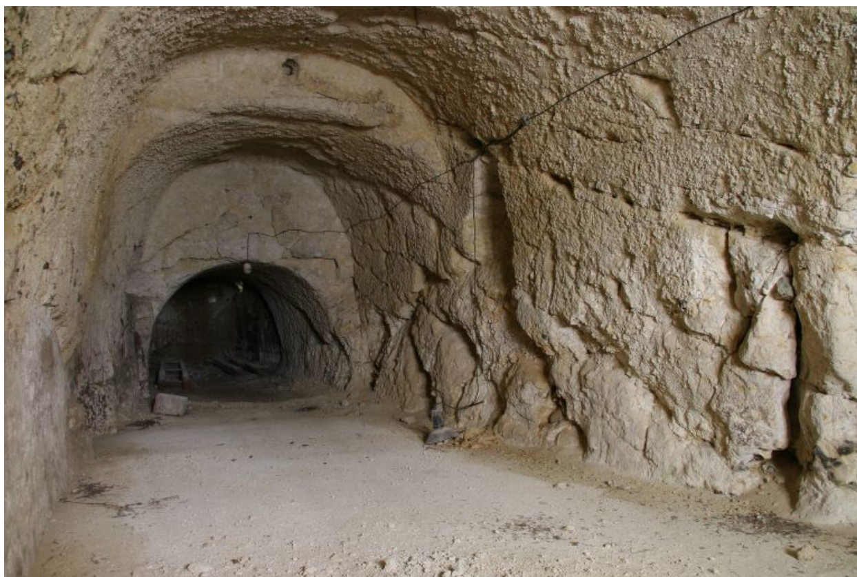
Ancien magasin de stockage creusés dans le tuf.
