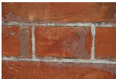
Faux joints dans un enduit fausse brique. Phot. Jean-Baptiste Darrasse IVR52_20057203468NUCA
