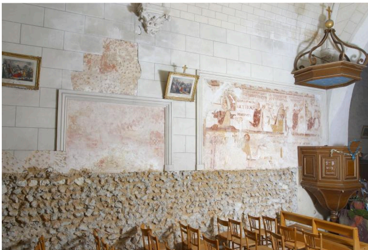
Nef, mur nord : vue d'ensemble.
