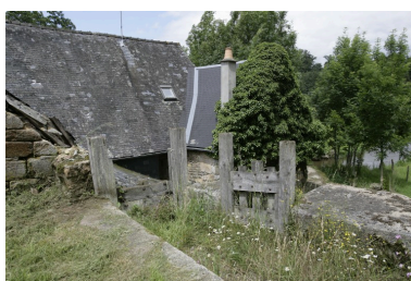
L'extrémité du canal d'alimentation : à gauche, la vanne d'alimentation des roues ; à droite, la vanne de décharge. Phot. François Lasa IVR52_20075300396NUCA
