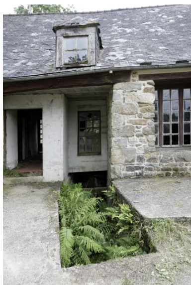
Vue partielle du moulin depuis l'ouest : l'emplacement du canal de fuite. Phot. François Lasa IVR52_20075300399NUCA
