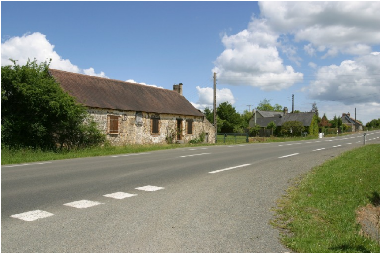
Les anciens logis accolés situés à l'ouest, vus depuis le sud-ouest.
