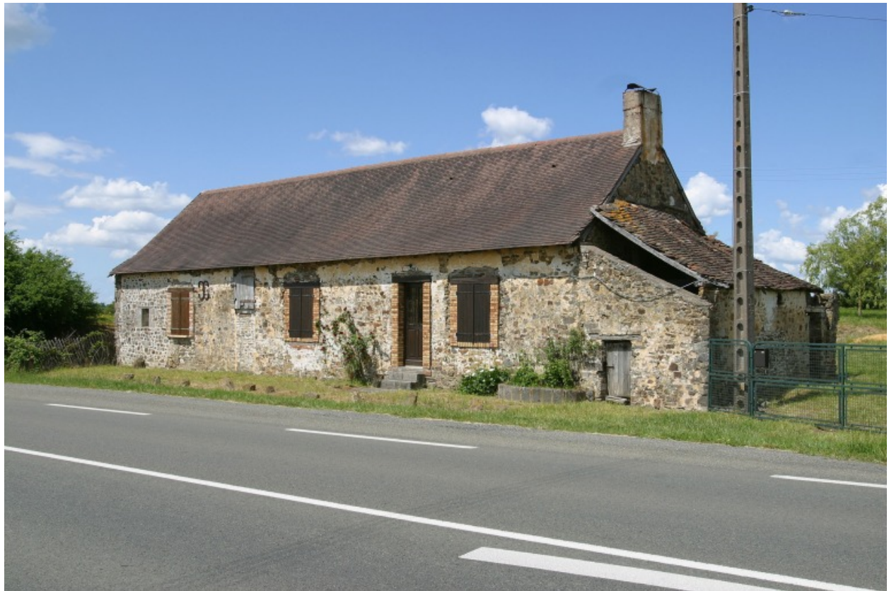
Les anciens logis accolés situés à l'ouest vu depuis le sud-est.
