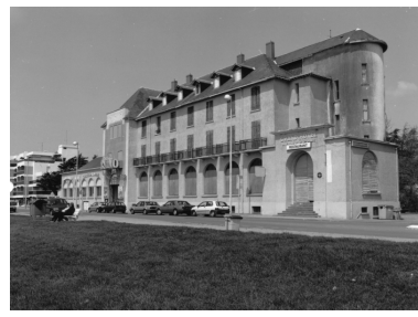
Elévation antérieure vue du sud-ouest. Phot. Denis Pillet IVR52_19964400753X
