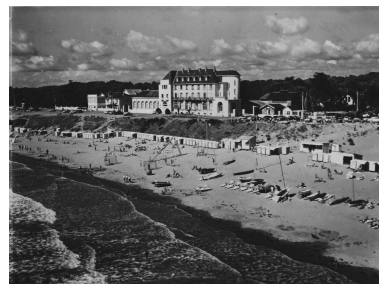
Vue d'ensemble, photographie aérienne. Repro. Denis Pillet IVR52_20094400894NUCA
