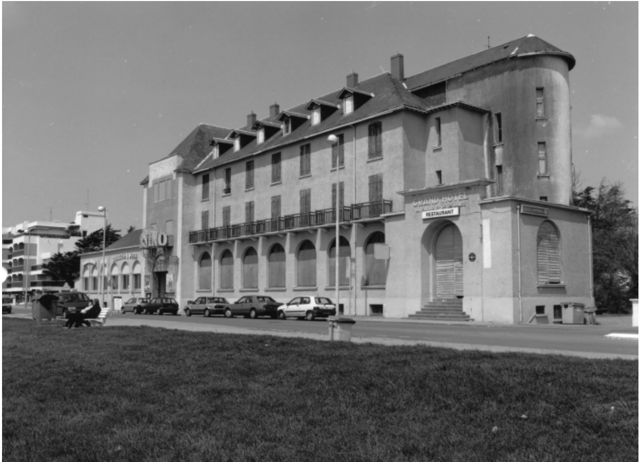
Elévation antérieure vue du sud-ouest.
