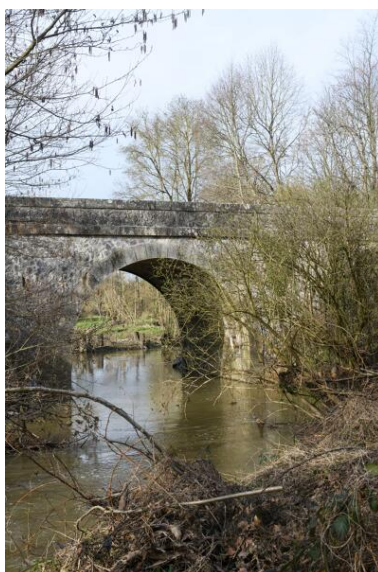
Le pont Laurent. Vue depuis le sud-est. Phot. Armelle Maugin IVR52_20244900312NUCA
