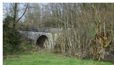
Le pont Laurent. Vue depuis le sud-est. Phot. Armelle Maugin IVR52_20244900310NUCA
