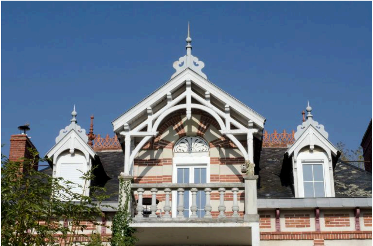
Détail des lucarnes de la façade sur Loire.
