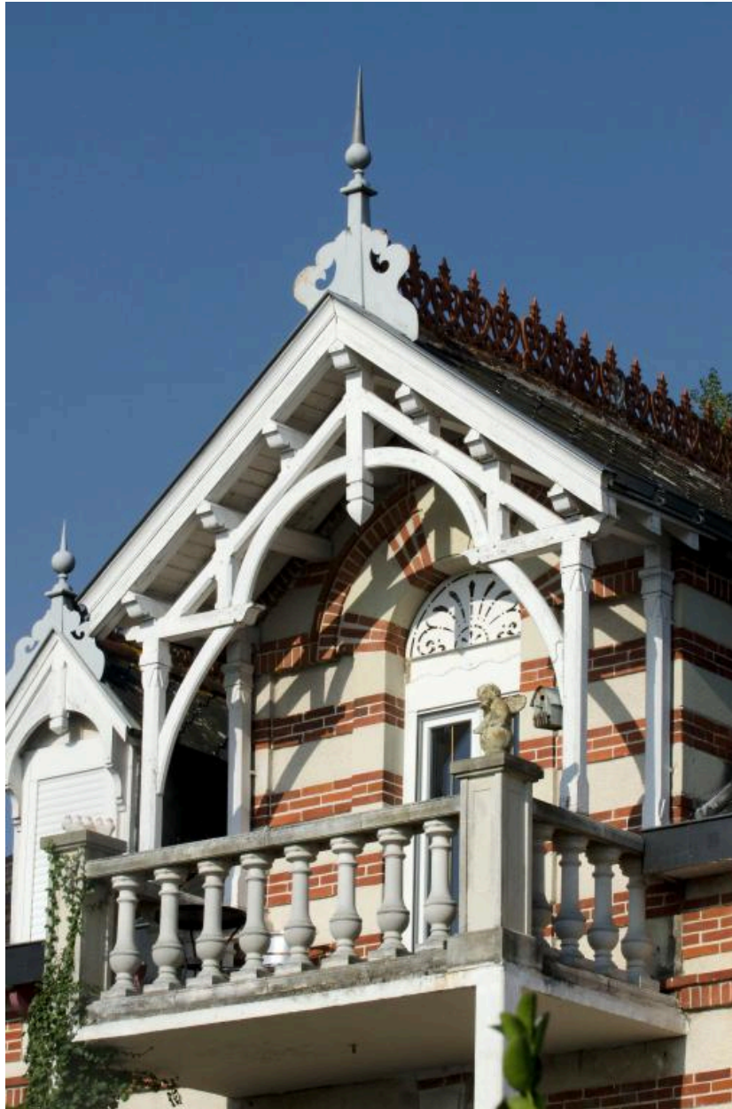
Détail de la lucarne centrale de la façade sur Loire.
