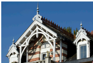
Détail des fermes débordantes. Phot. Bruno Rousseau IVR52_20134901609NUCA
