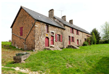
Alignement de deux logis et d'une grange-étable. Phot. Yves Guillotin IVR52_20195300495NUCA
