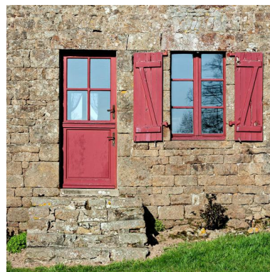
Alignement de deux logis et d'une grange-étable, porte et fenêtre du logis central. Phot. Yves Guillotin IVR52_20195300328NUCA
