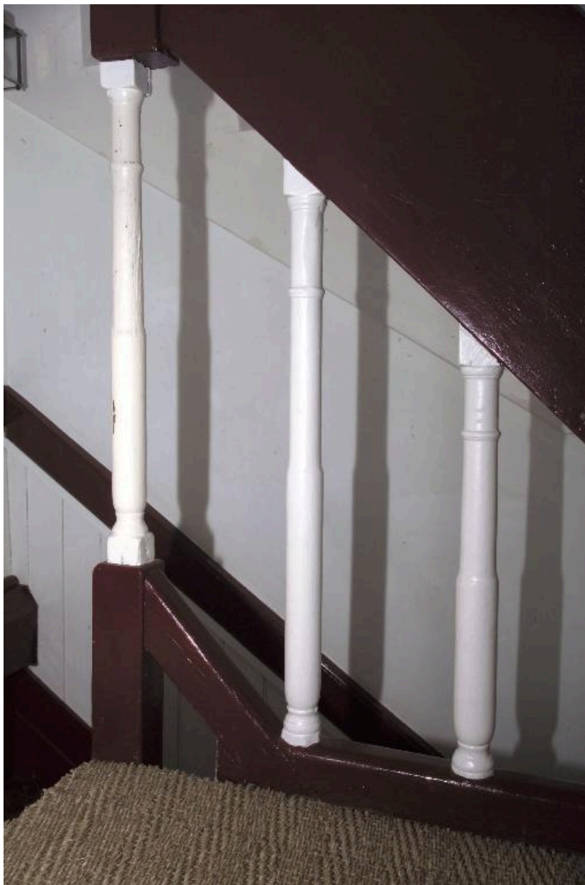
L'escalier, détail des balustres.
