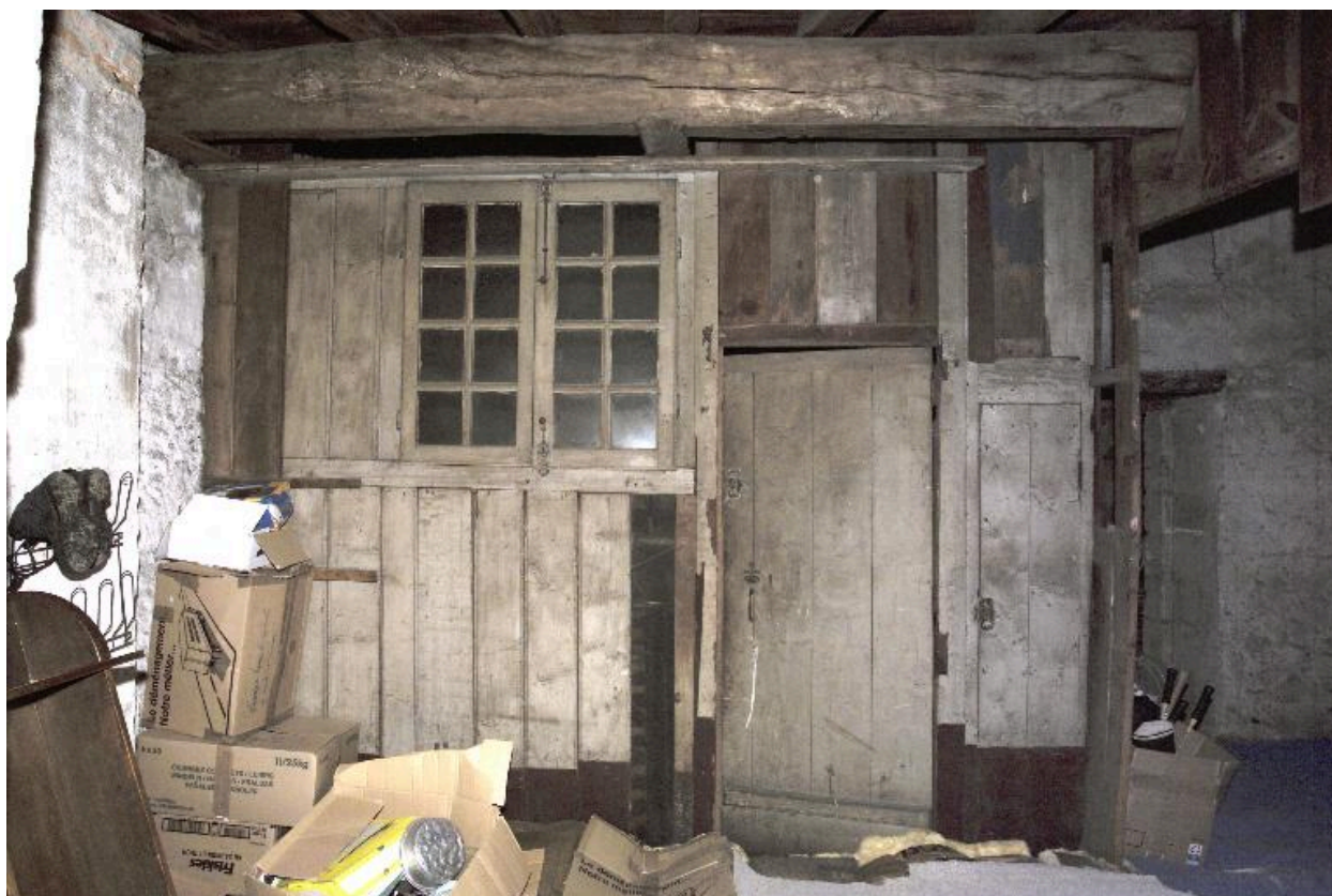
La cloison isolant l'arrivée de l'escalier du niveau de comble.
