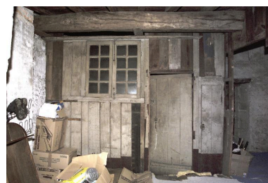
La cloison isolant l'arrivée de l'escalier du niveau de comble. Phot. Denis Pillet IVR52_20034400536NUCA
