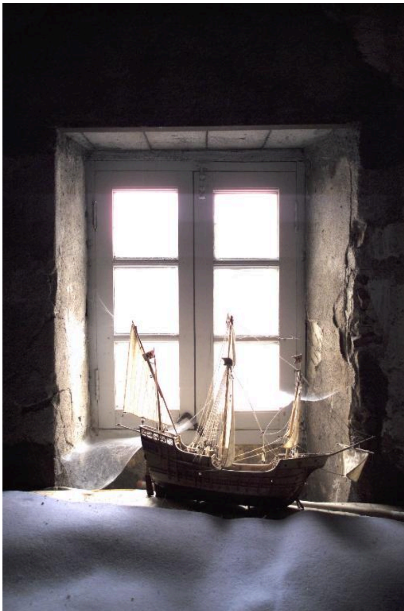
Le comble, détail de l'ouverture située à l'ouest.
