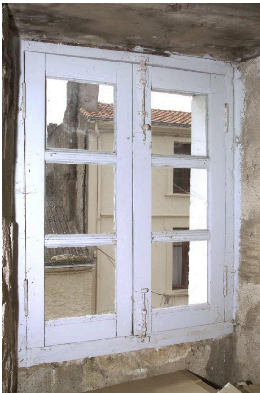
Le comble, détail de l'ouverture située à l'est.
