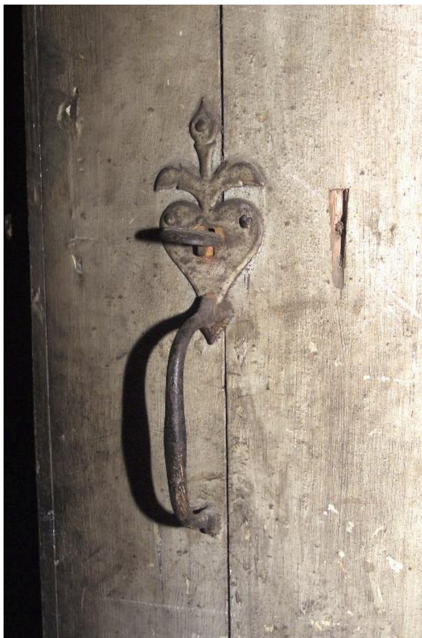
La porte d'accès au niveau de comble, détail.
