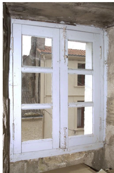
Le comble, détail de l'ouverture située à l'est. Phot. Denis Pillet IVR52_20034400535NUCA
