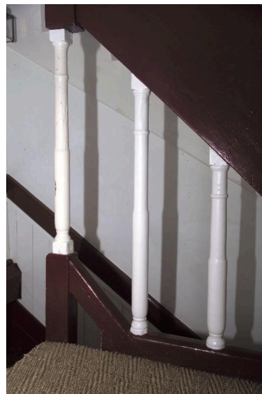
L'escalier, détail des balustres. Phot. Denis Pillet IVR52_20034400530NUCA
