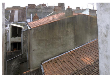
Au centre, vue de la couverture et du pignon ouest. Phot. Denis Pillet IVR52_20034400508NUCA
