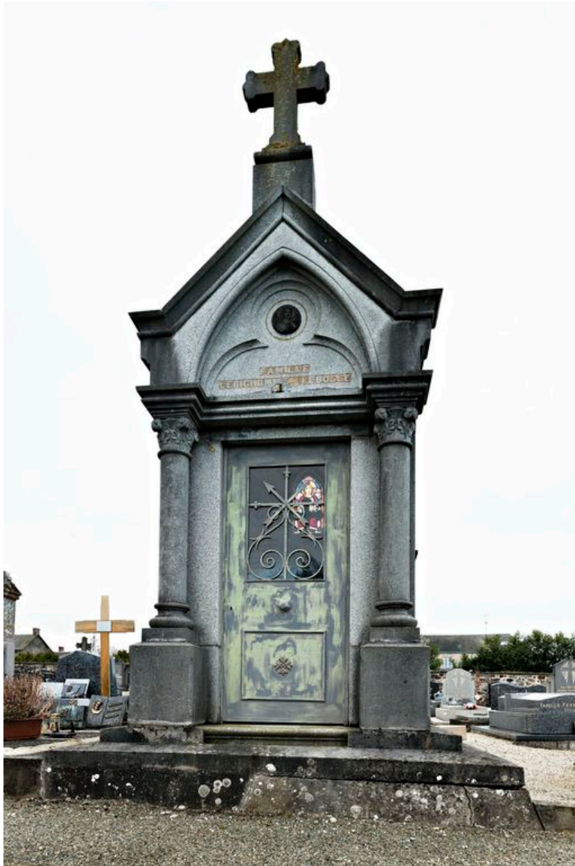
Vue d'ensemble de la chapelle.
