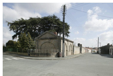
Vue extérieure prise du sud-ouest. Au premier plan, la maison du gardien. Phot. Patrice Giraud IVR52_20078500058NUCA
