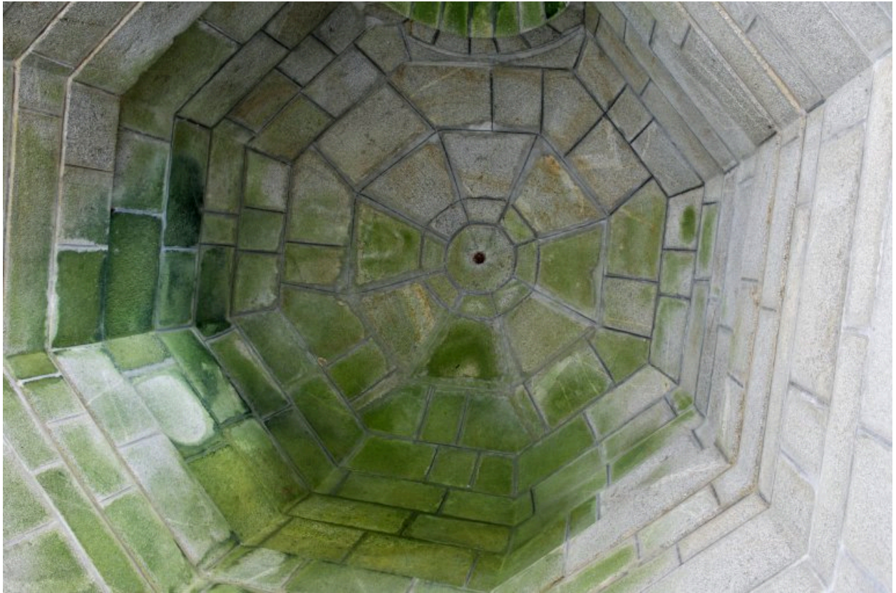
Vue de la coupole de la chapelle.
