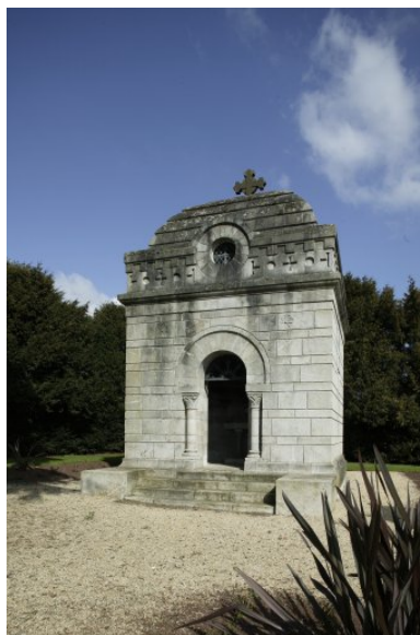
La chapelle. Phot. Patrice Giraud IVR52_20078500055NUCA
