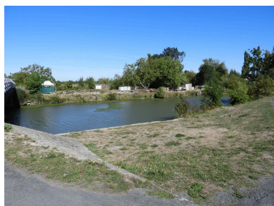
La cale vue depuis le sud. Phot. Yannis Suire IVR52_20198500291NUCA
