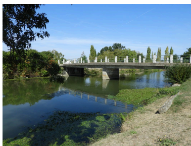
Les abords du pont, en aval, vus depuis le sud. Phot. Yannis Suire IVR52_20198500401NUCA
