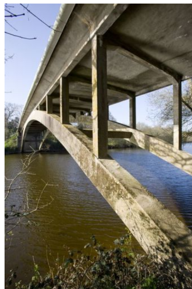
Le pont de la Ramée : détail des arcs paraboliques. Phot. Yves Guillotin IVR52_20114400201NUCA
