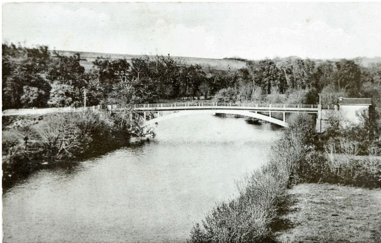
Le pont de la Ramée : vue aérienne, vers 1960.
