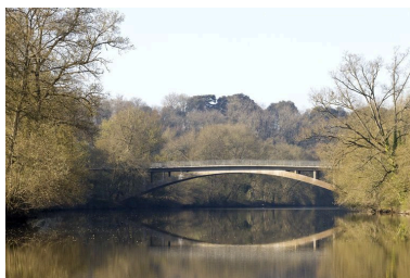
Le pont de la Ramée. Phot. Yves Guillotin IVR52_20114400202NUCA
