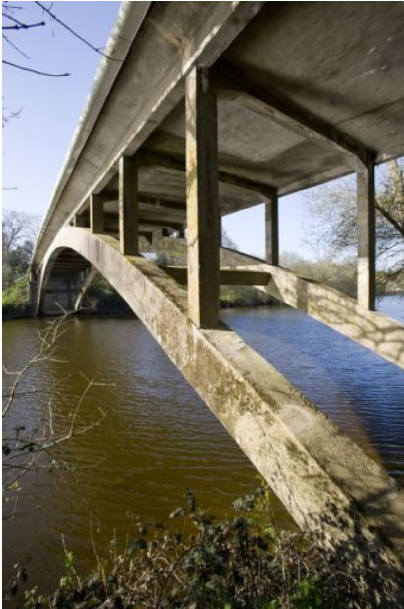
Le pont de la Ramée : détail des arcs paraboliques.
