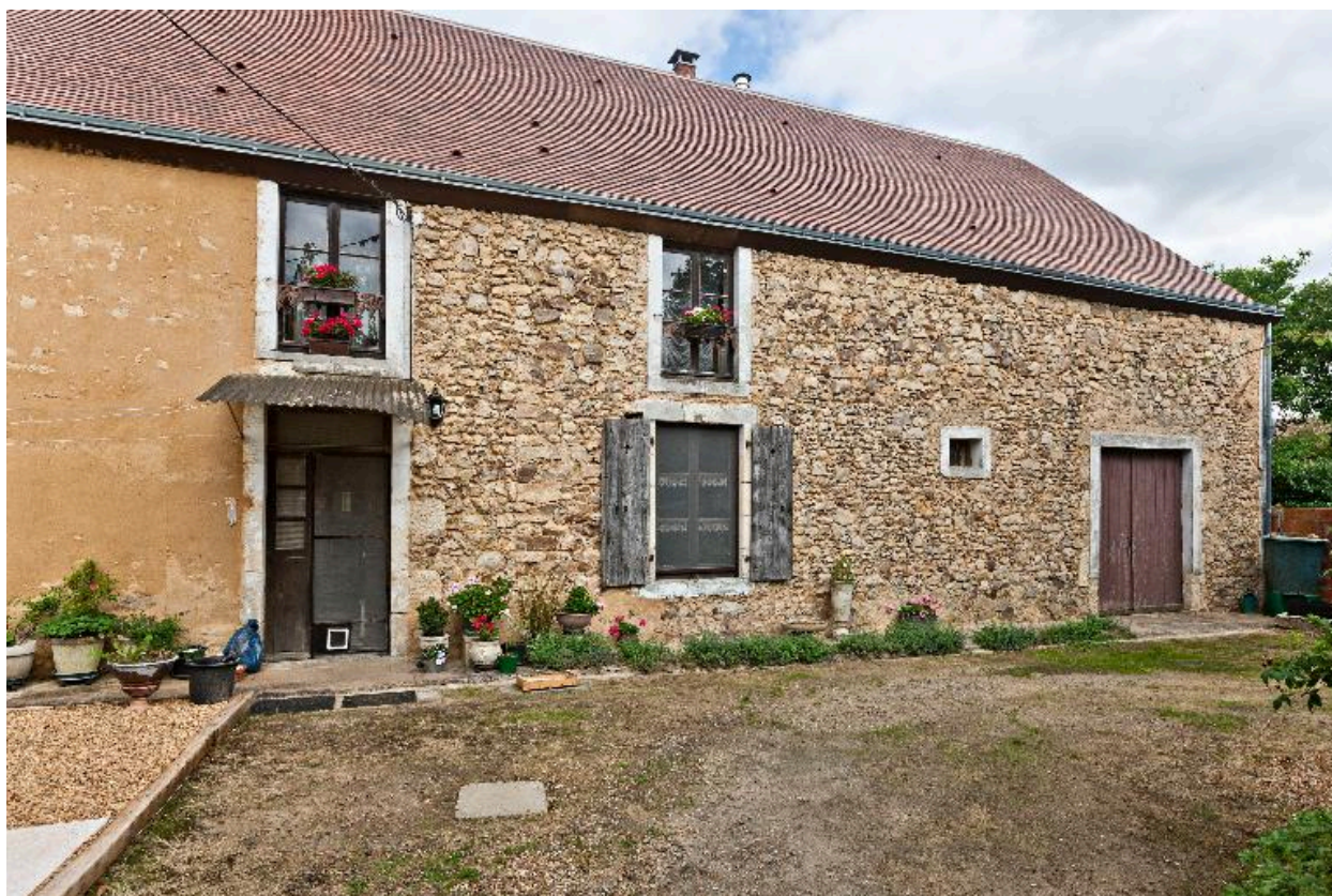
Partie droite de l'élévation sur cour.
