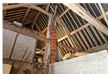
Vue intérieure de la grange. La charpente est celle de la grange aux dîmes du XVIIIe siècle. A gauche, la partie basse en moellons de la cloison date de l'appropriation en école en 1828, la partie haute en pan-de-bois hourdé de briques enduites de la surélévation du 4e quart du XIXe siècle.
