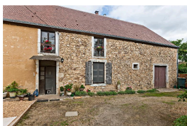
Partie droite de l'élévation sur cour. Phot. Yves Guillotin IVR52_20147201815NUCA
