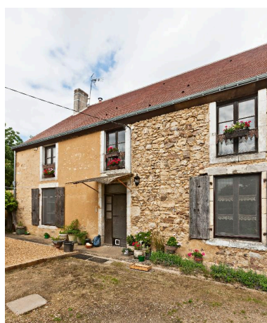
Partie gauche de l'élévation sur cour. Phot. Yves Guillotin IVR52_20147201816NUCA
