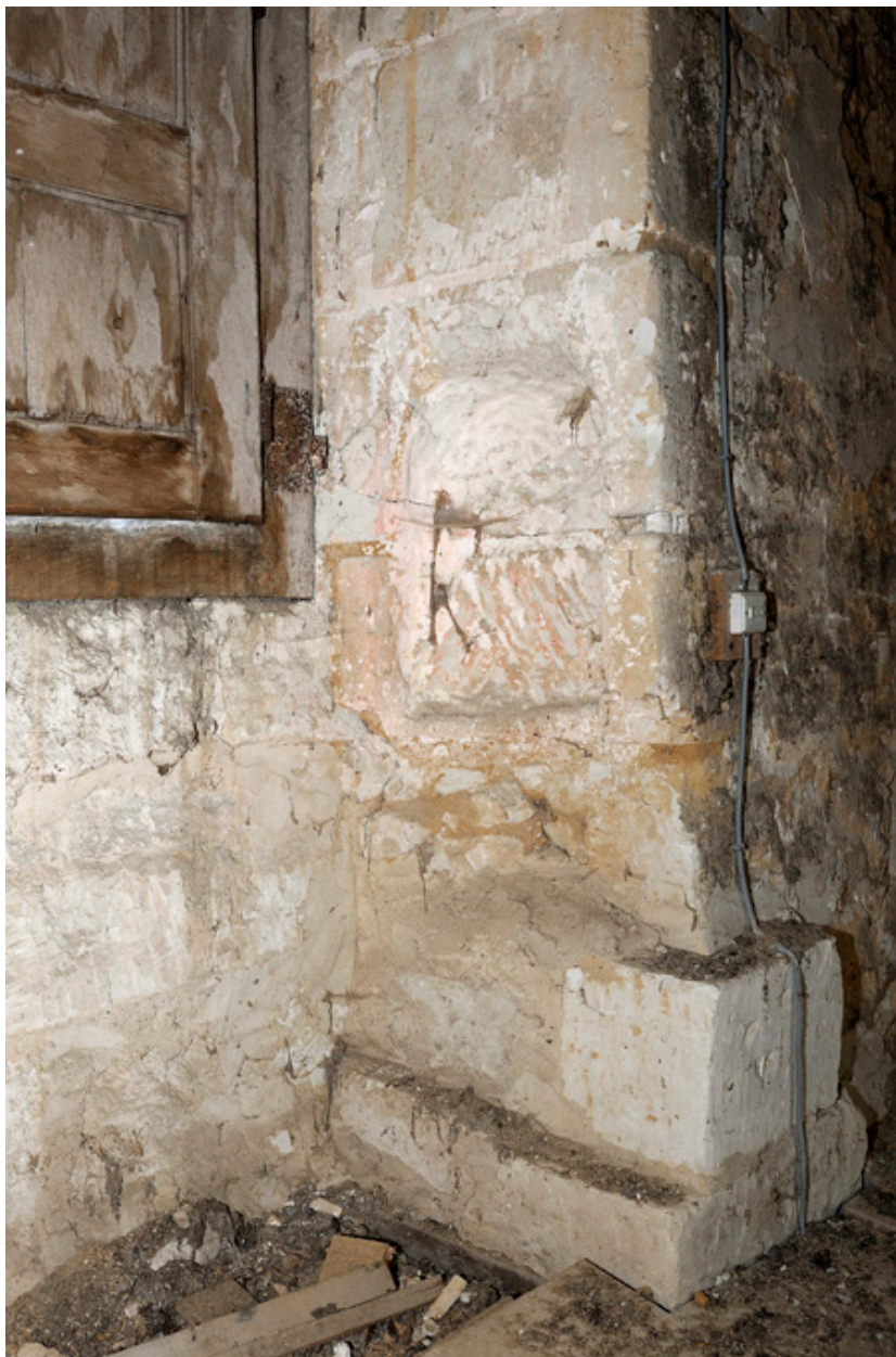
Etage, salle ouest : niche dans l'embrasure intérieure de la croisée nord.
