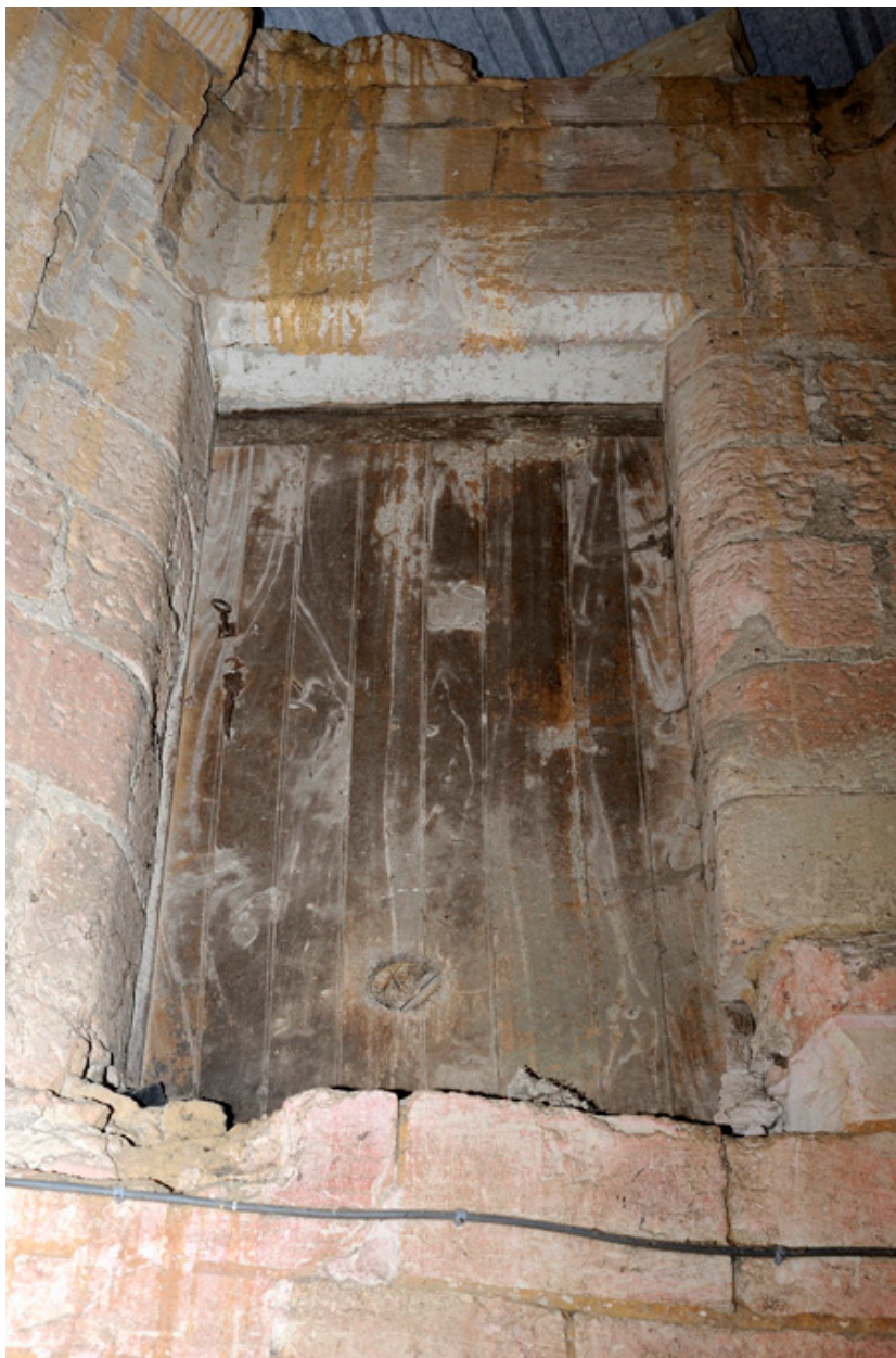
Tourelle d'escalier, porte de la salle est à l'étage : encadrement chanfreiné à congé et linteau à accolade.
