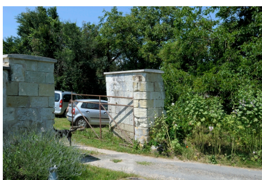
Vestiges des piédroits de l'ancienne porte de l'enceinte manoriale. Phot. Bruno Rousseau IVR52_20134900884NUCA
