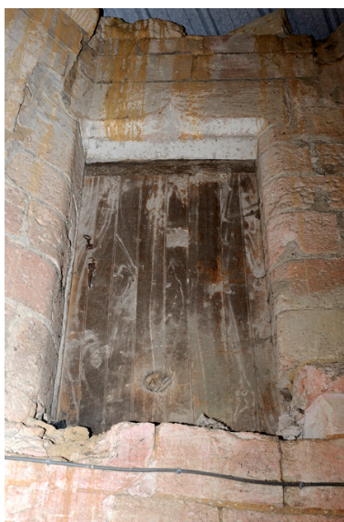
Tourelle d'escalier, porte de la salle est à l'étage : encadrement chanfreiné à congé et linteau à accolade. Phot. Bruno Rousseau, Phot. Youenn Communeau IVR52_20114900714NUCA
