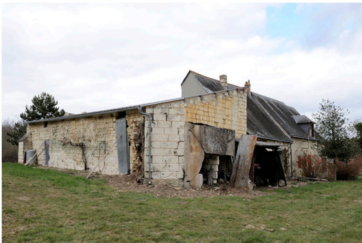
Façade postérieure (depuis le sud-est).
