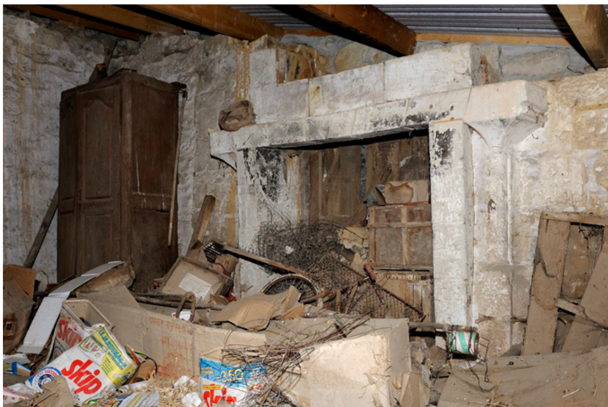
Étage, salle est : cheminée (seconde moitié XVe ou début XVIe siècle, très remaniée).
