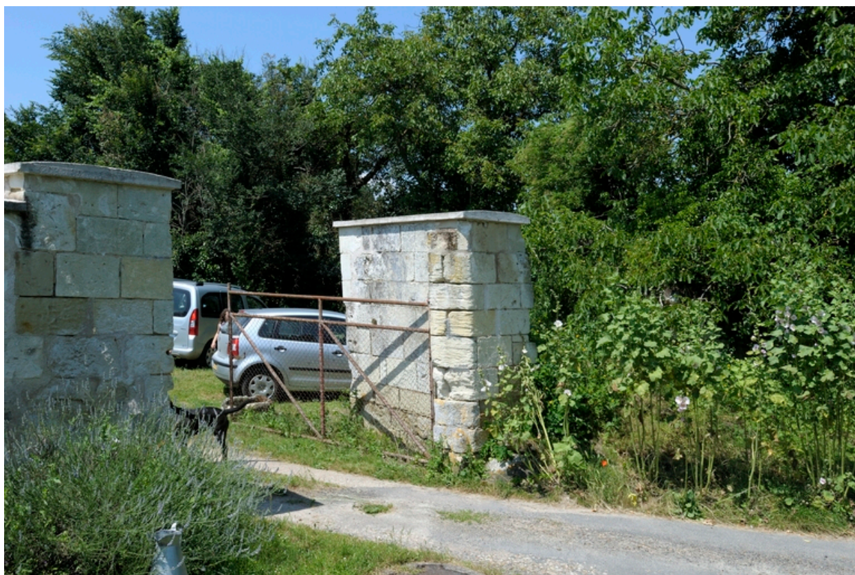
Vestiges des piédroits de l'ancienne porte de l'enceinte manoriale.
