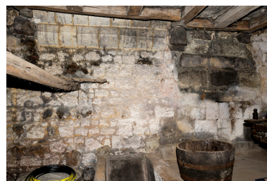
Rez-de-chaussée, salle est : base de la cheminée de la salle du dessus. Phot. Bruno Rousseau, Phot. Youenn Communeau IVR52_20114900715NUCA
