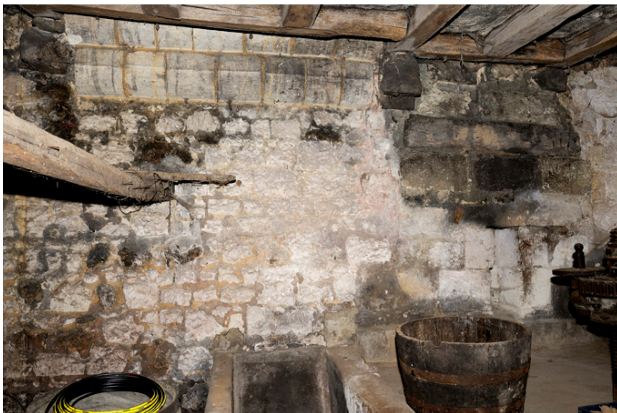
Rez-de-chaussée, salle est : base de la cheminée de la salle du dessus.
