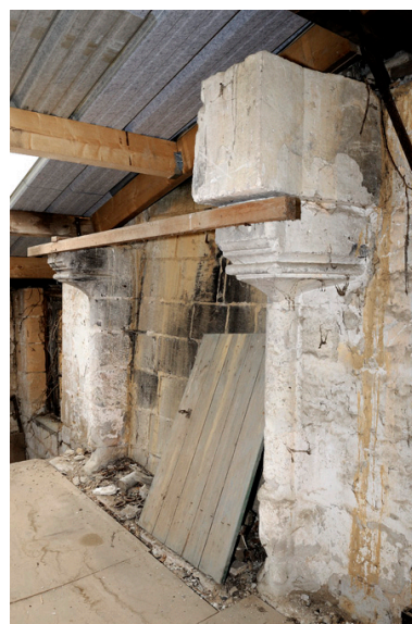
Etage, salle ouest : cheminée (profil). Phot. Bruno Rousseau, Phot. Youenn Communeau IVR52_20114900710NUCA
