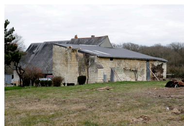
Façade postérieure (depuis le sud-ouest). Phot. Bruno Rousseau, Phot. Youenn Communeau IVR52_20114900726NUCA
