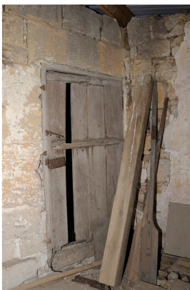
Etage, salle ouest : porte. Phot. Bruno Rousseau, Phot. Youenn Communeau IVR52_20114900707NUCA
