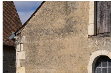
Pignon est, détail de l'inscription : "HOTEL DE FRAN[CE]". Phot. Jeanne Minier IVR52_20257200317NUCA
