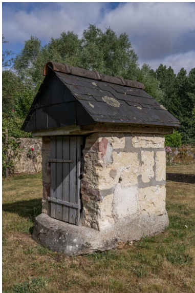
Puits. Phot. Jeanne Minier IVR52_20257200318NUCA
