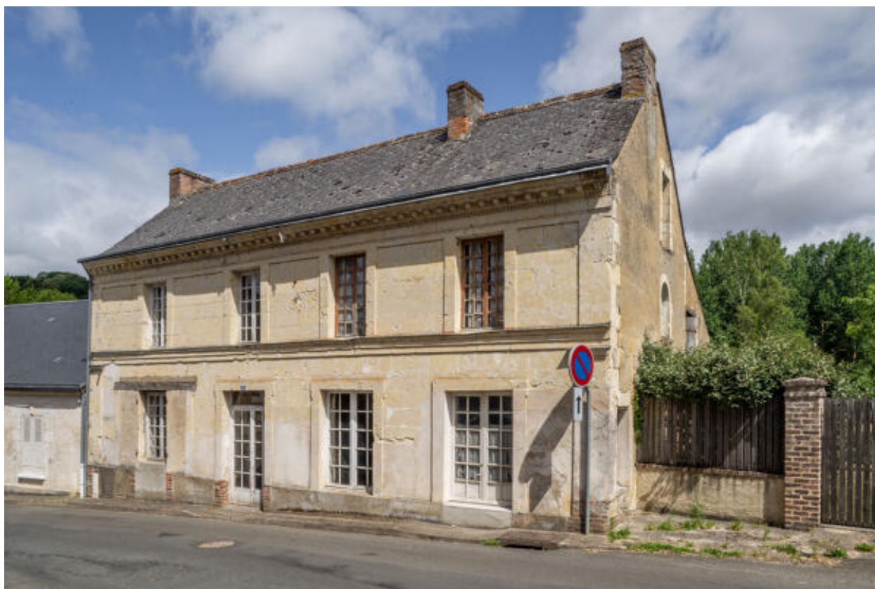
Vue de la façade depuis la rue de la Boule d'Or.
