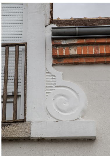
Un détail de lucarne, rue de Belfort. Phot. Pierre-Bernard Fourny IVR52_20187201531NUCA
