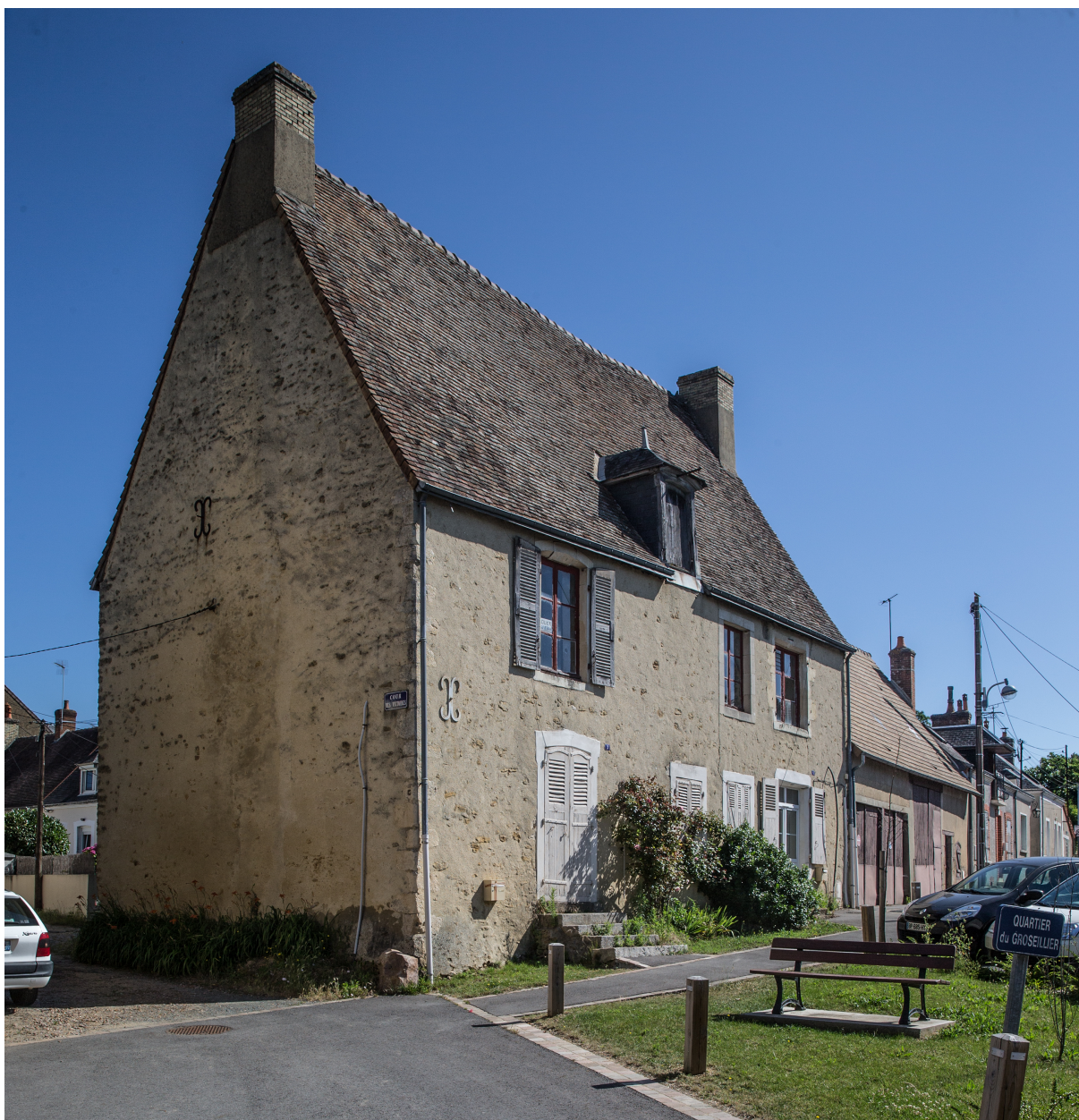
Une maison du XVIe siècle avec tour d'escalier, quartier du Groisiller.
