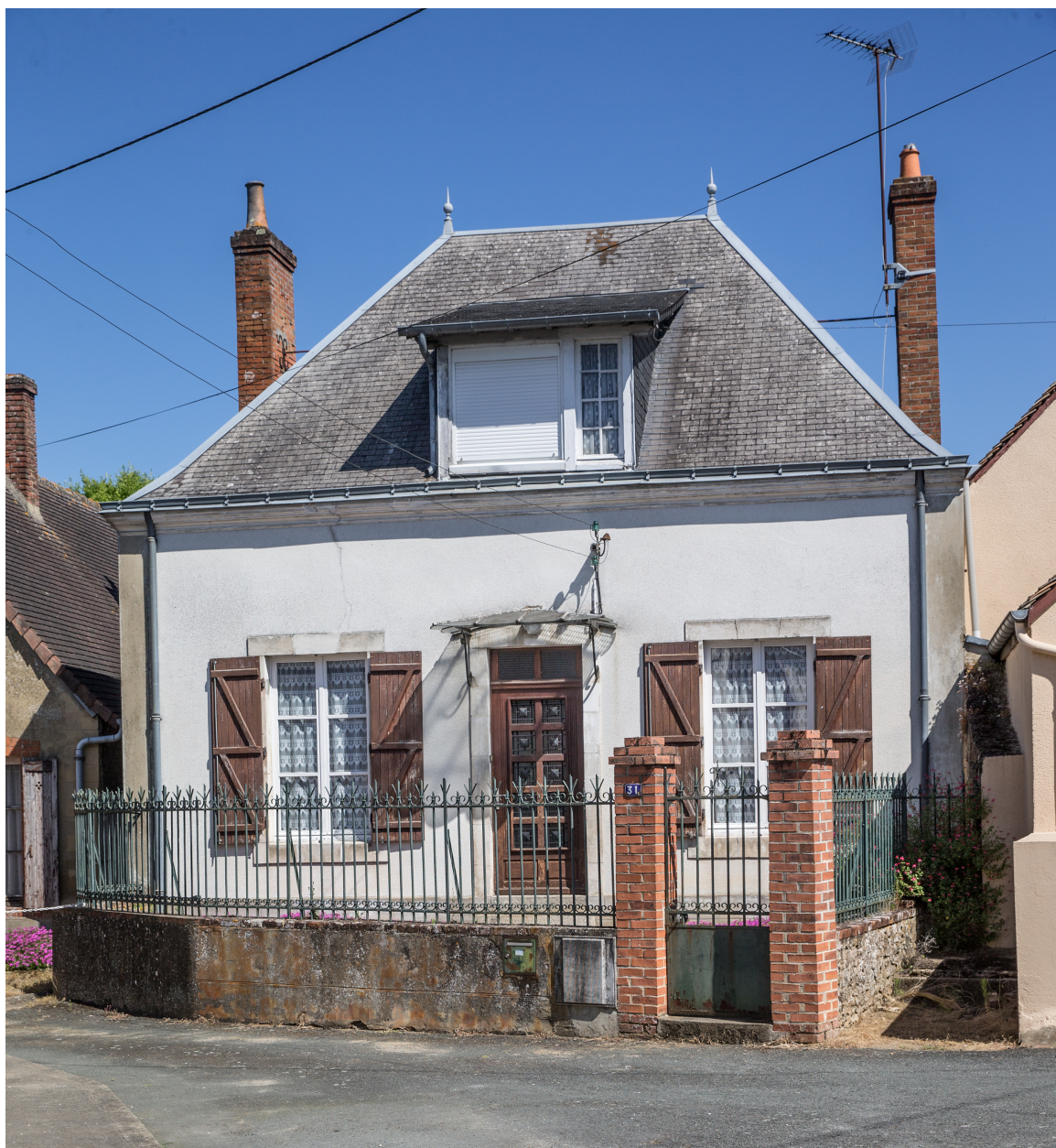
Une maison de faubourg du XIXe siècle, rue de la Rochelle.
