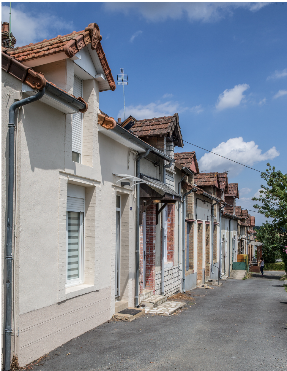
Des logements de série du début du XXe siècle, avenue Carnot.
