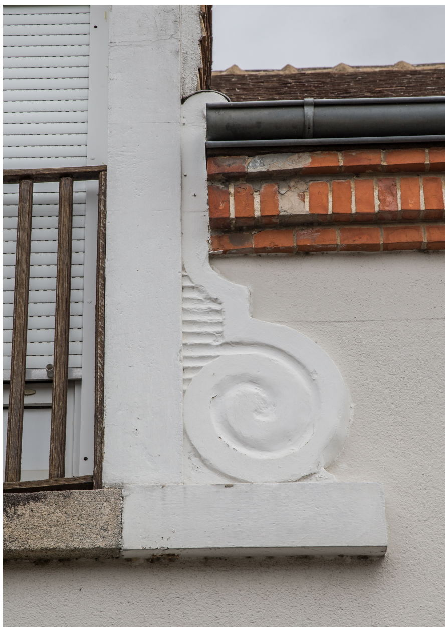
Un détail de lucarne, rue de Belfort.
