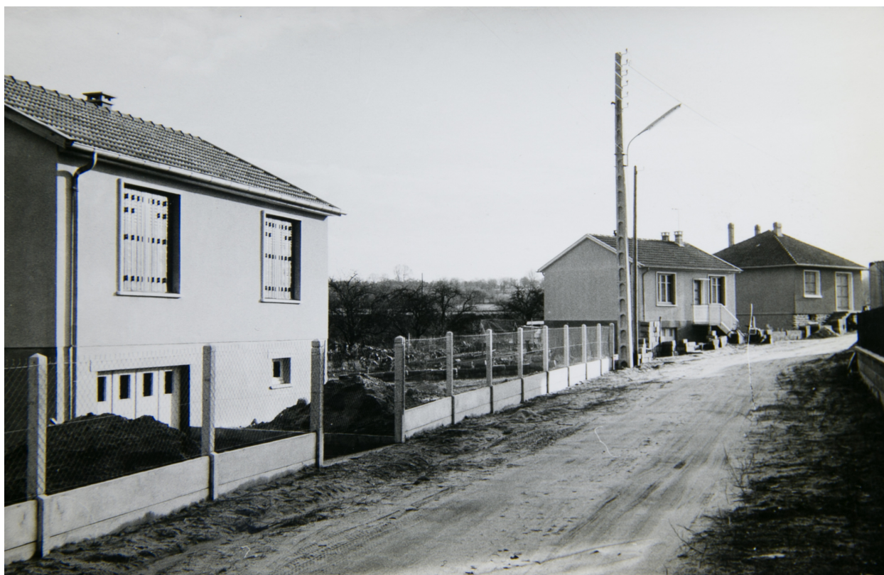
La construction d'un lotissement, photographie années 1960.
