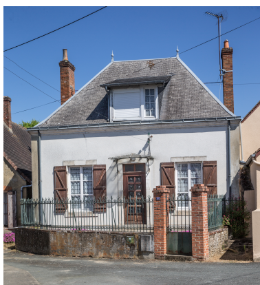
Une maison de faubourg du XIXe siècle, rue de la Rochelle. Phot. Pierre-Bernard Fourny IVR52_20187201039NUCA
