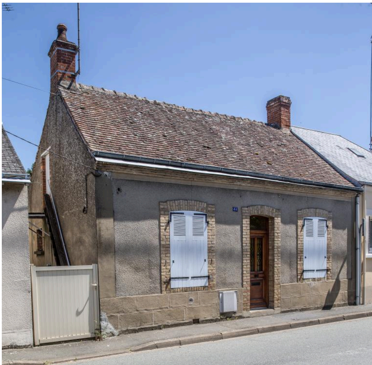
Une maison de faubourg du XIXe siècle, rue de la Gare.
