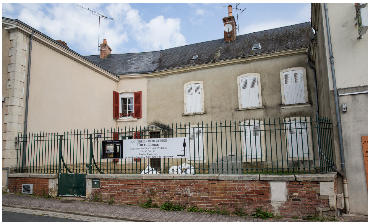
Une maison du XVIIIe siècle, rue de la République.
