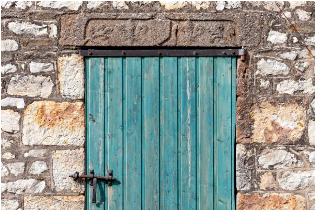
Corps de bâtiment nord-ouest, linteau de porte armorié.
