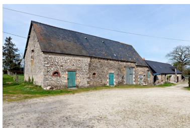
Corps de bâtiment nord-ouest. Phot. Yves Guillotin IVR52_20195300453NUCA
