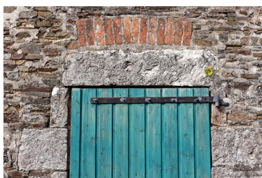
Corps de bâtiment nord-ouest, encadrement de porte en grès blanc, arc de décharge en brique. Phot. Yves Guillotin IVR52_20195300455NUCA
