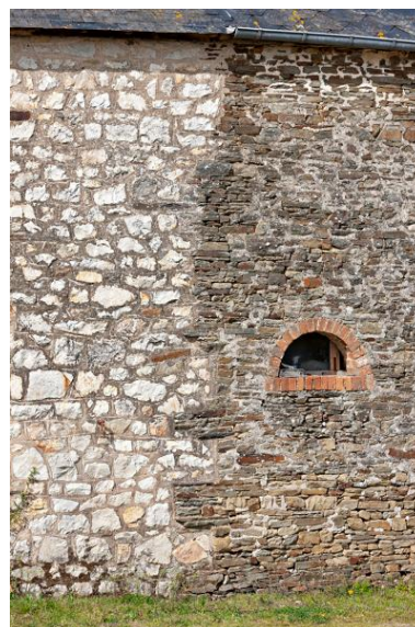
Corps de bâtiment nord-ouest, mur sud, jonction entre la maçonnerie en moellon de grès blanc et en moellon de grès. Phot. Yves Guillotin IVR52_20195300456NUCA
