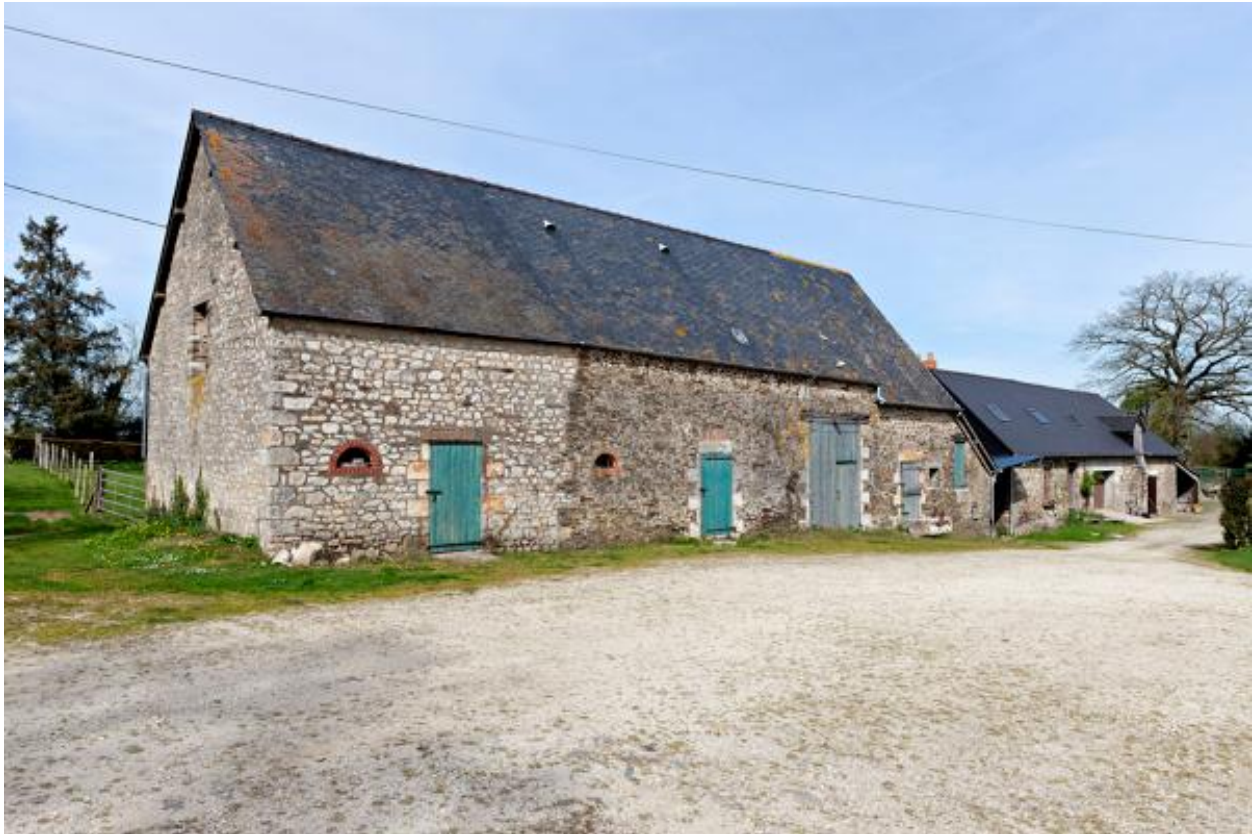
Corps de bâtiment nord-ouest.
