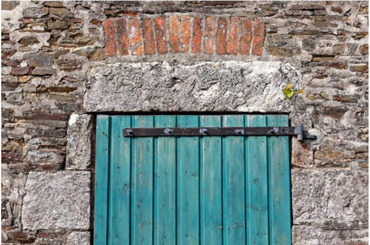
Corps de bâtiment nord-ouest, encadrement de porte en grès blanc, arc de décharge en brique.
