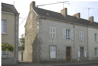
Vue depuis la rue. Phot. François Lasa IVR52_20045303122NUCA
