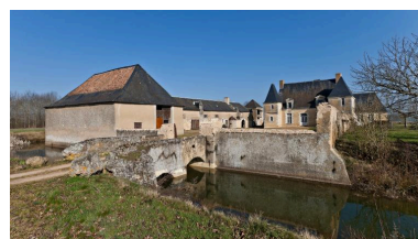
Manoir de la Faverie. Phot. Yves Guillotin IVR52_20127200345NUCA
