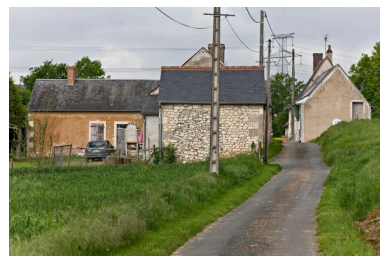
Le Pin. Phot. Yves Guillotin IVR52_20127201095NUCA
