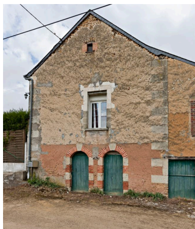
Le Pin. Phot. Yves Guillotin IVR52_20127201094NUCA
