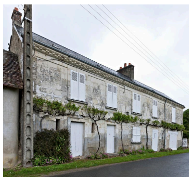
Château-Gontier. Phot. Yves Guillotin IVR52_20127201156NUCA
