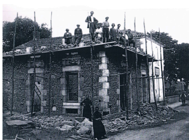
Construction de la maison en 1926. Phot. Yannis (reproduction) Suire IVR52_20198503708NUCA
