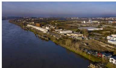
Vue aérienne du quai Émile-Cormerais. Phot. Pierre-Bernard Fourny IVR52_20214401139NUCA
