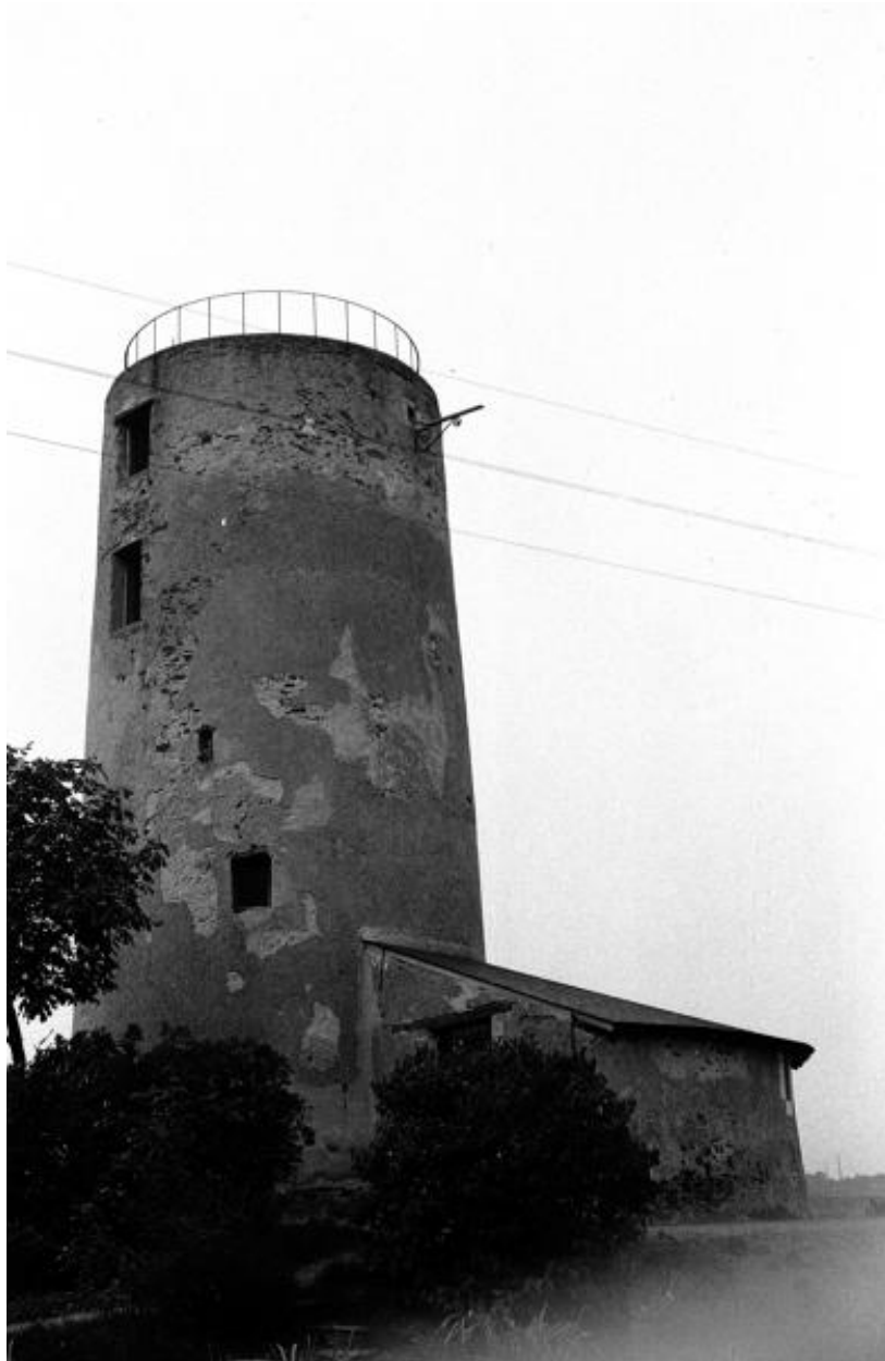
Moulin-tour du Lion dit Moulin-Neuf, avant restauration de sa toiture, Montjean-sur-Loire.
