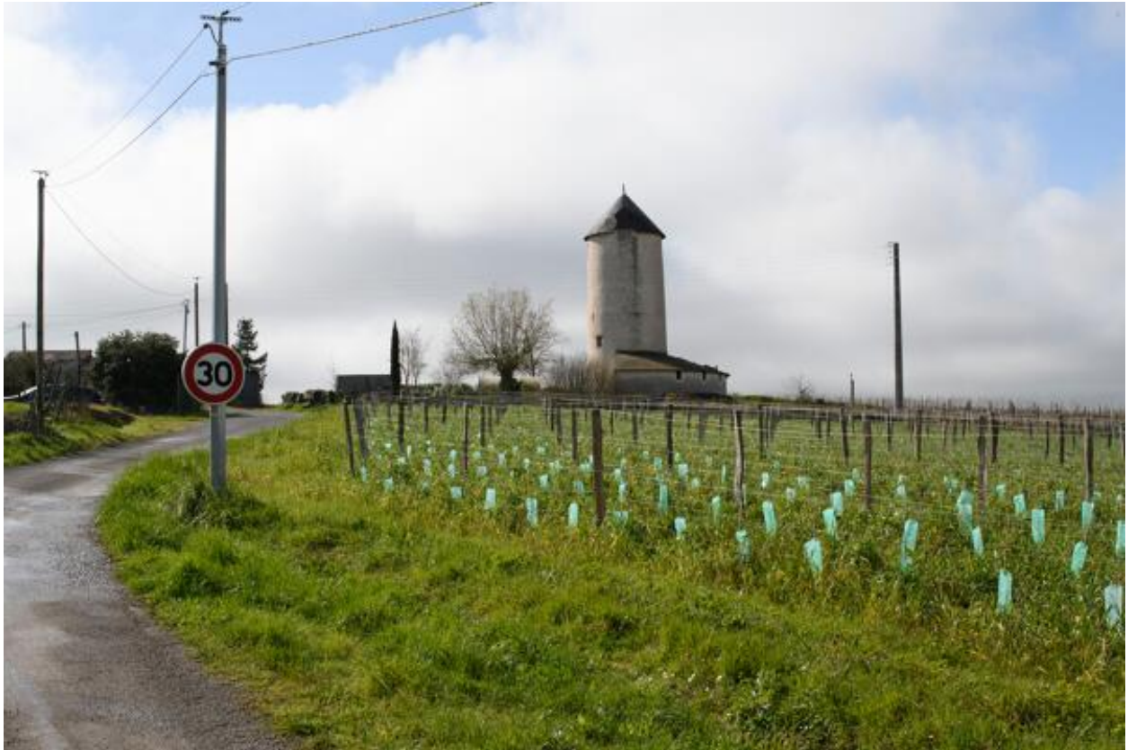
Vue d'ensemble du moulin-tour du Lion dit Moulin-Neuf, Montjean-sur-Loire.
