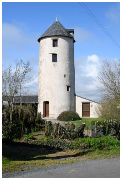
Façade principale, moulin-tour du Lion dit Moulin-Neuf, Montjean-sur-Loire. Phot. Armelle Maugin IVR52_20244900333NUCA
