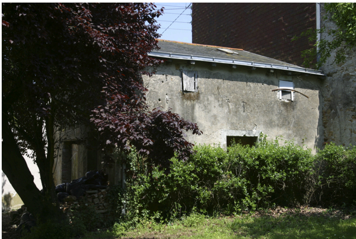
La dépendance située à gauche du portail d'entrée de la partie adressée n° 50 quai Chassagne, vue prise depuis le jardin (façade actuellement aveugle sur le quai).
