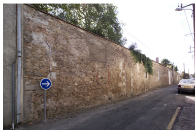
Le mur de clôture rue Beausoleil. Phot. Denis Pillet IVR52_20034401051NUCA
