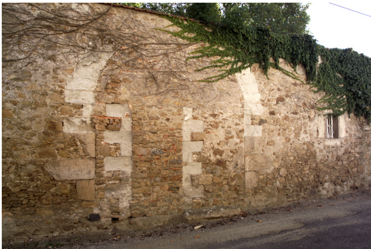
Le mur de clôture rue Beausoleil, l'ancien portail d'entrée.
