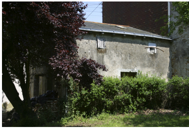
La dépendance située à gauche du portail d'entrée de la partie adressée n° 50 quai Chassagne, vue prise depuis le jardin (façade actuellement aveugle sur le quai). Phot. Denis Pillet IVR52_20034400285NUCA
