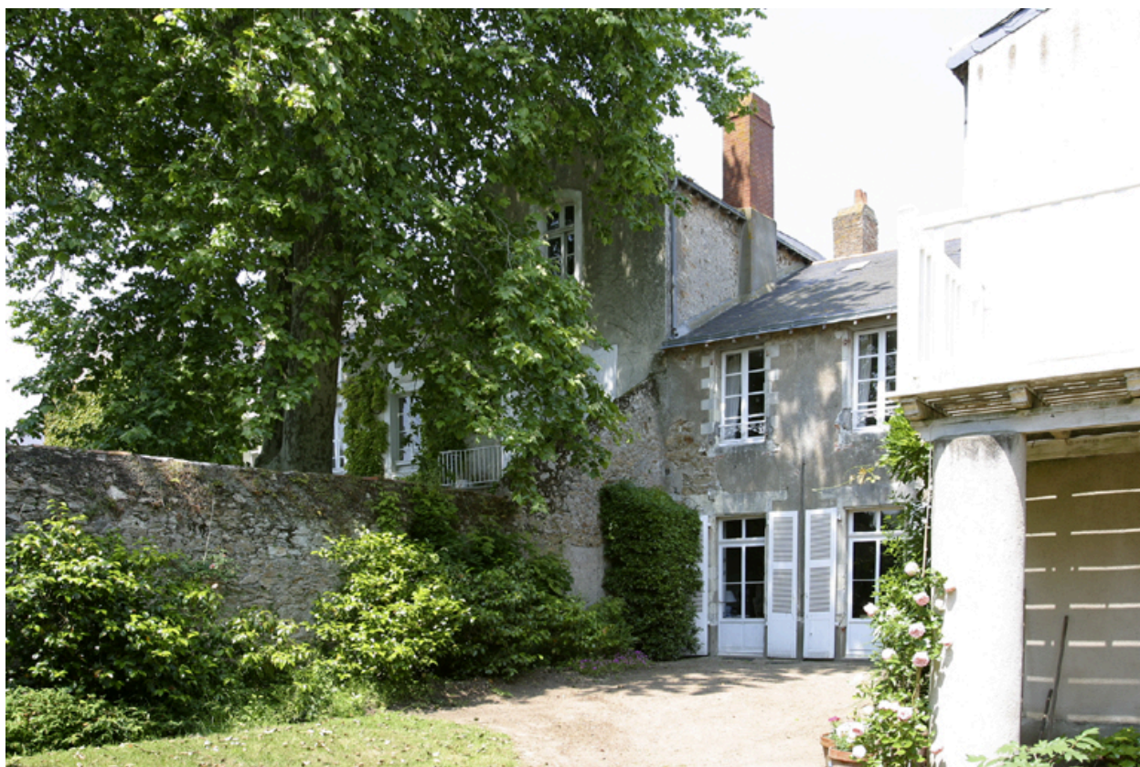
Vue d'ensemble depuis le jardin adressé n° 50.
