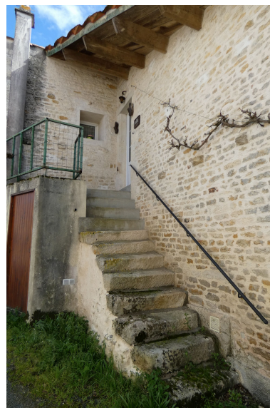
L'escalier extérieur. Phot. Yannis Suire IVR52_20238500921NUCA
