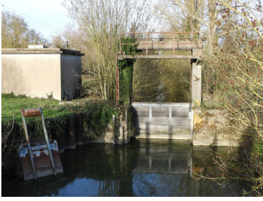
Le barrage vu depuis le sud-ouest, côté aval. Phot. Yannis Suire IVR52_20198500594NUCA
