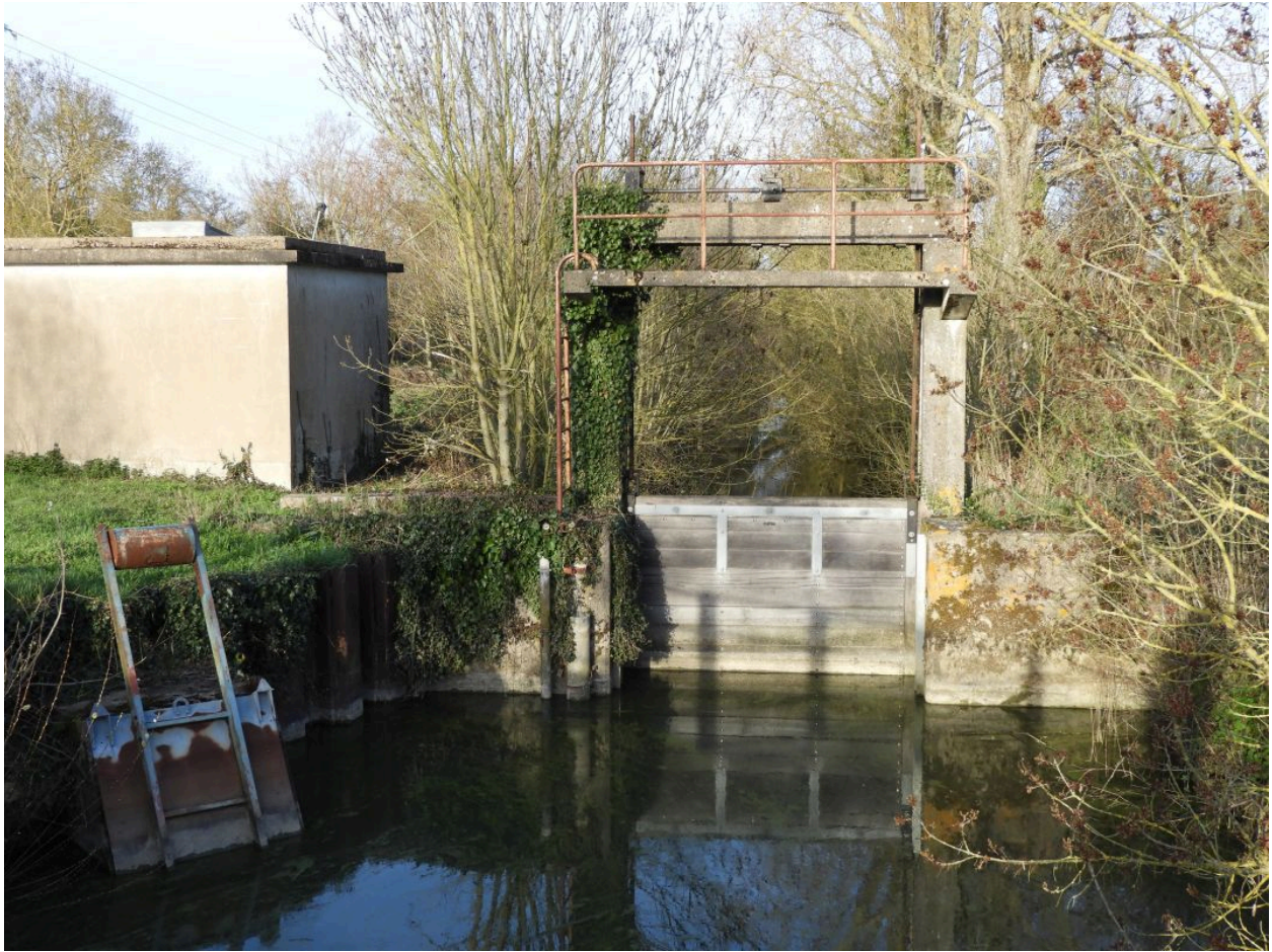
Le barrage vu depuis le sud-ouest, côté aval.
