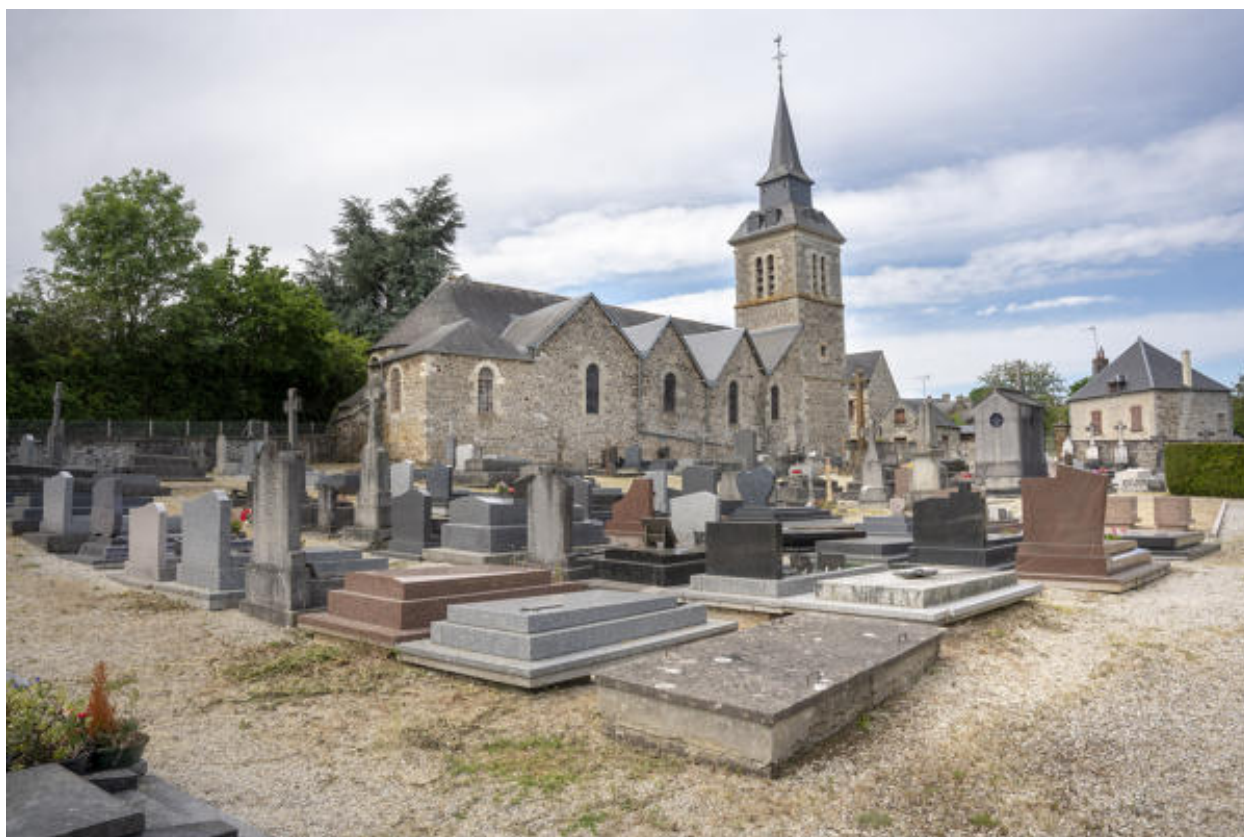
L'église depuis le nord-est, côté cimetière.
