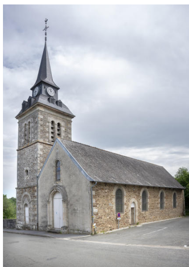
L'église depuis le sud-ouest. Phot. Pierre-Bernard Fourny
