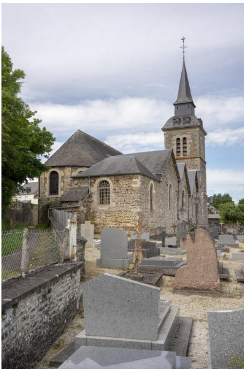
L'église depuis le nord-est, côté cimetière.
