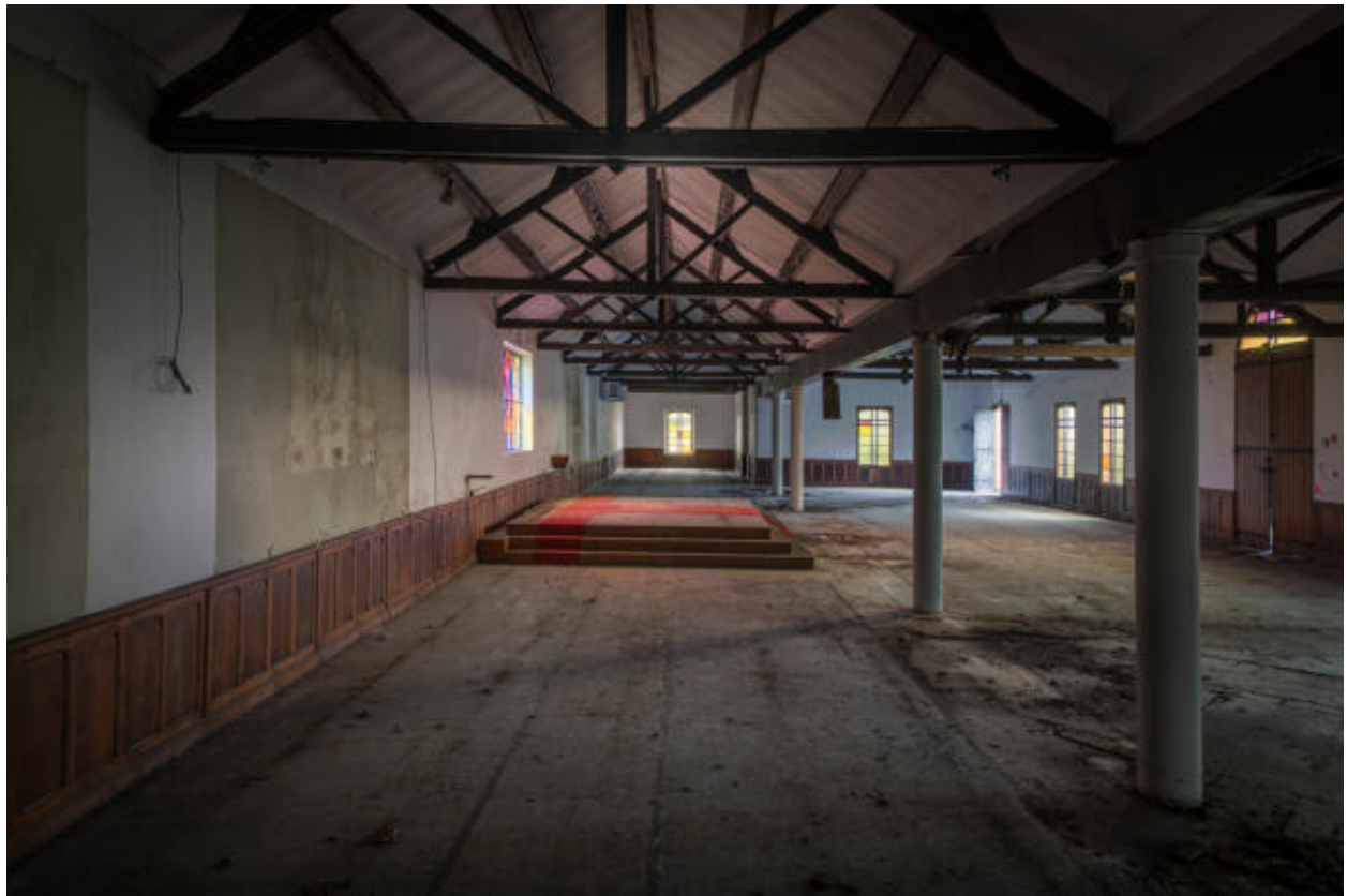
Vue de la chapelle depuis le bras nord.
