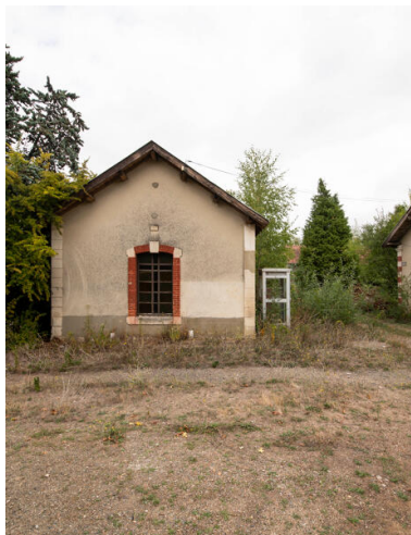
Vue du pignon de la chapelle. Phot. Thierry Seldubuisson IVR52_20227201062NUCA
