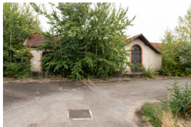
Vue de la chapelle depuis l'ouest. Phot. Thierry Seldubuisson IVR52_20227201068NUCA
