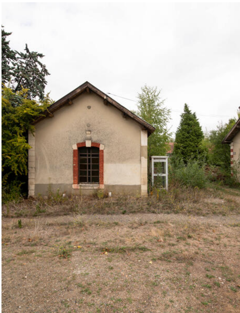
Vue du pignon de la chapelle.
