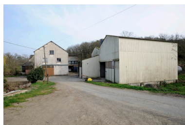
Vue du moulin de Robat et de ses agrandissements, côté nord-ouest. Phot. Bruno Rousseau IVR52_20114900828NUCA
