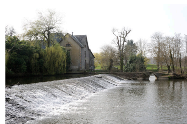
Vue du moulin de Robat, de sa chaussée et de son pont, depuis la rive nord de La Moine. Phot. Bruno Rousseau IVR52_20114900824NUCA
