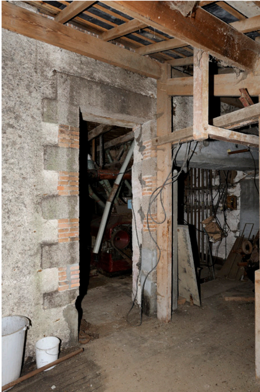
Mur sud du moulin englobé dans une structure plus récente.
