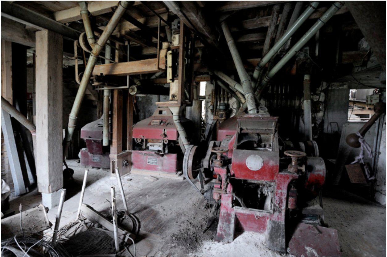
Broyeurs situés au premier étage.
