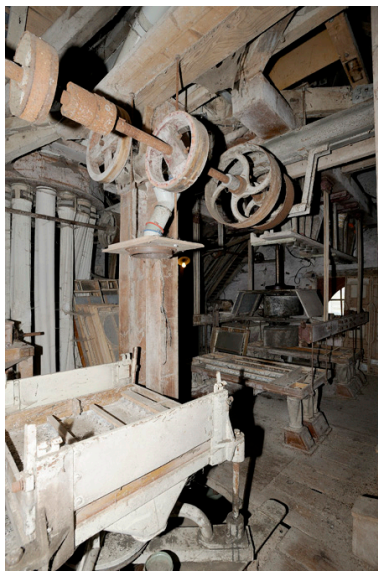
Plansichters situés au troisième étage. Phot. Bruno Rousseau IVR52_20114900818NUCA
