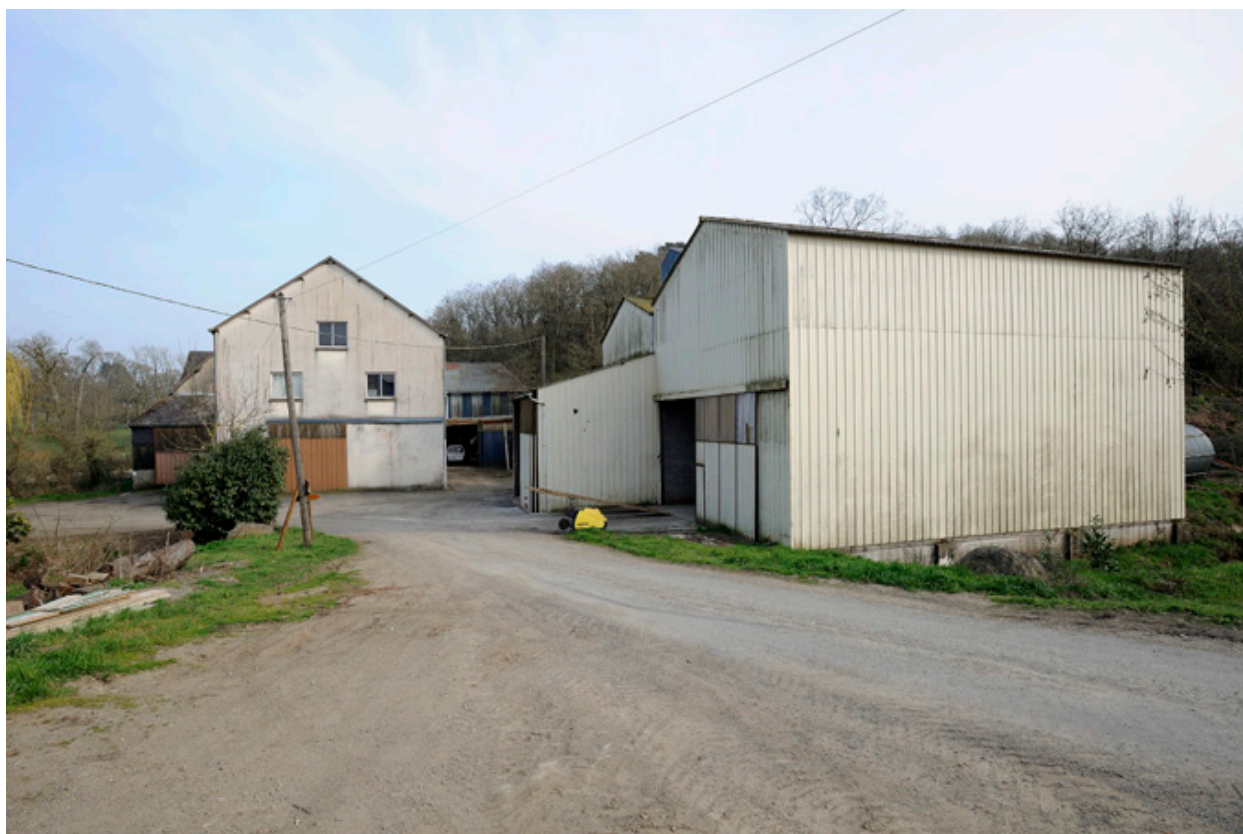
Vue du moulin de Robat et de ses agrandissements, côté nord-ouest.
