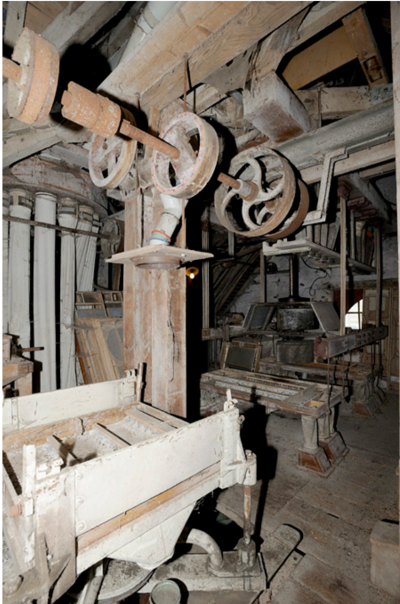
Plansichters situés au troisième étage.
