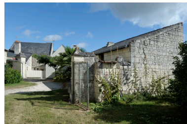
Dépendances agricoles et habitations, vue d'ensemble. Phot. Bruno Rousseau IVR52_20124901582NUCA
