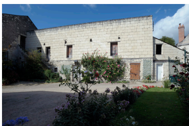
Dépendances agricoles de la seconde moitié du XVIII e siècle, rehaussées d'un niveau au XIX e siècle. Phot. Bruno Rousseau IVR52_20124901583NUCA
