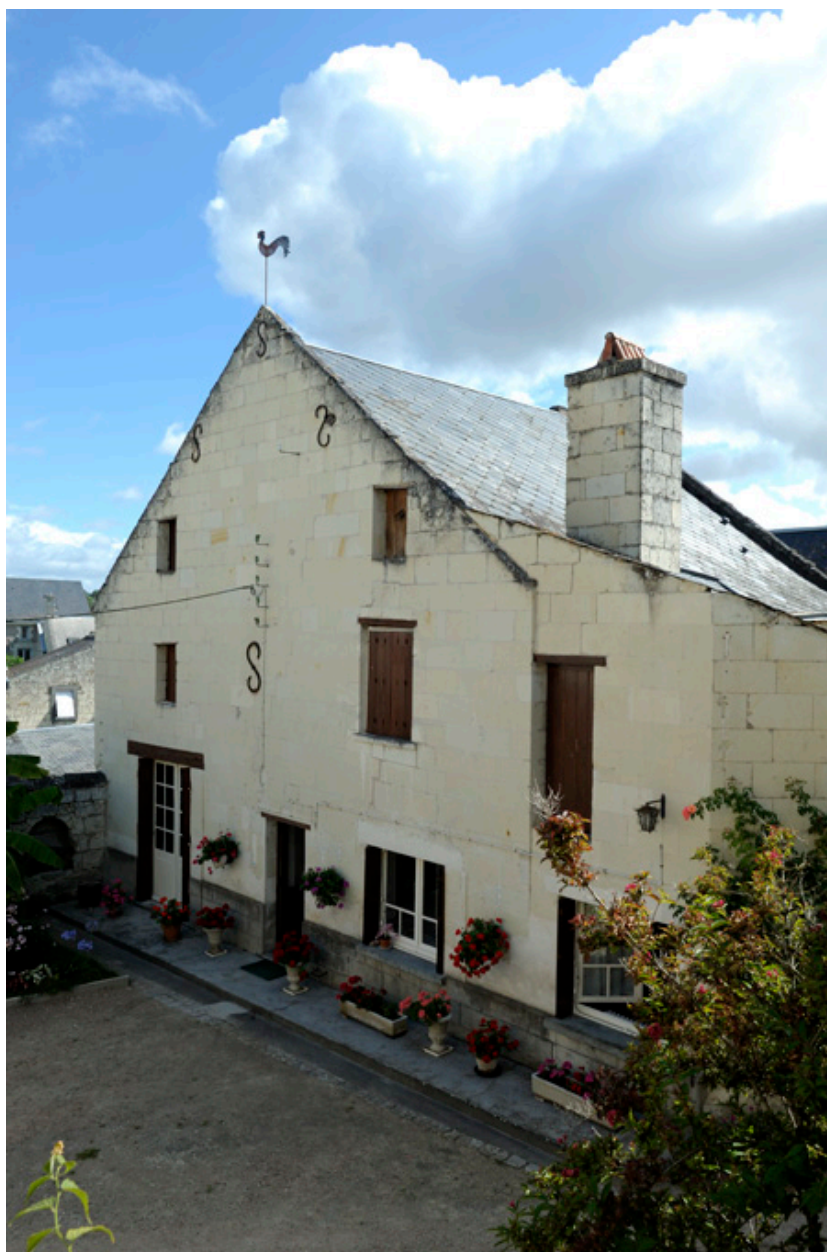
Extensions ouest du bâtiment, première moitié XVIIIe siècle, remaniée au milieu du XIXe. Vue d'ensemble.
