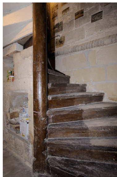
Escalier autrefois hors-œuvre, en vis et en charpente (seconde moitié du XVI e siècle). Noyau orné de congés à la base. Phot. Bruno Rousseau IVR52_20124901575NUCA
