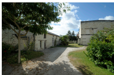
Dépendances agricoles du XIX e siècle (étables, grange). Phot. Bruno Rousseau IVR52_20124901579NUCA
