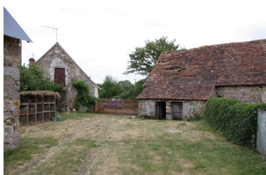
Le logis-étable et la seconde étable vus depuis l'ouest. Phot. François Lasa IVR52_20055301883NUCA
