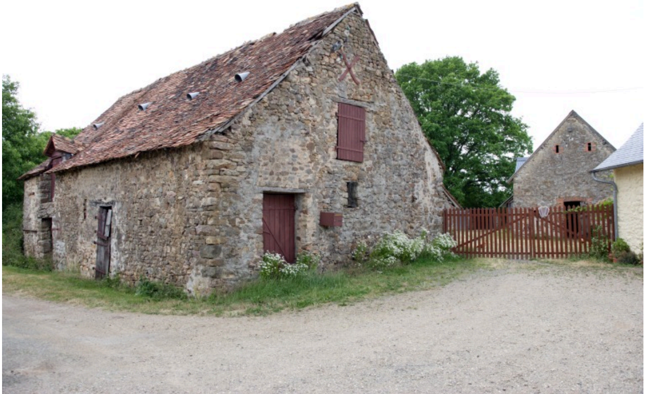
La seconde et la troisième étables vues depuis l'est.
