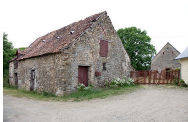
La seconde et la troisième étables vues depuis l'est. Phot. François Lasa IVR52_20055301880NUCA
