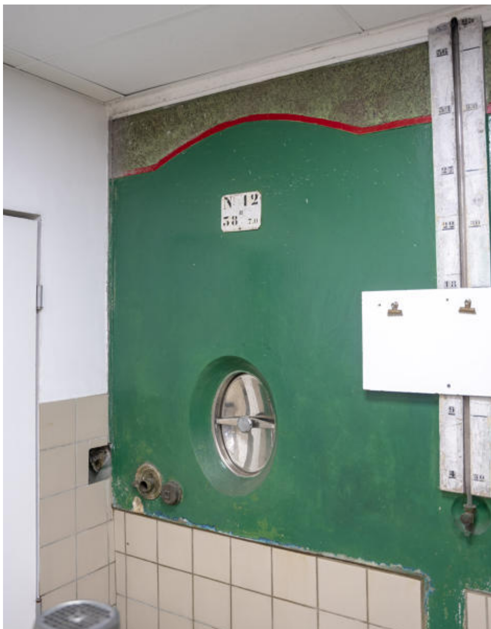
Détail d'une cuve, dans le bâtiment primitif.
