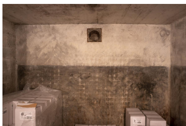
Détail d'une cellule de stockage. Phot. Pierre-Bernard Fourny IVR52_20224400025NUCA
