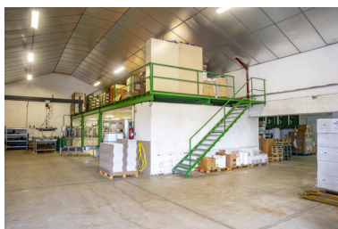
Vue générale du bâtiment primitif, depuis l'entrée. Phot. Pierre-Bernard Fourny IVR52_20224400022NUCA
