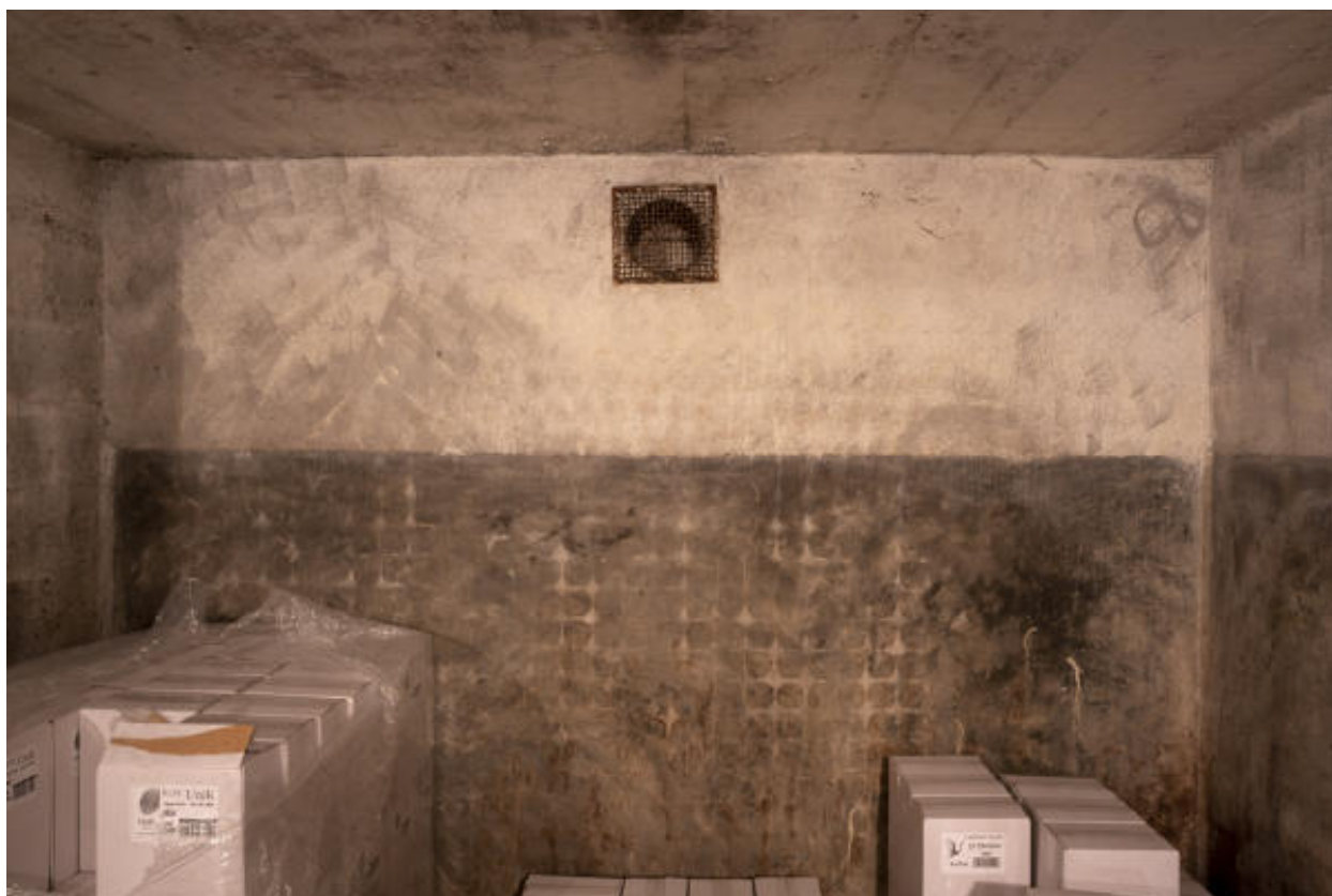
Détail d'une cellule de stockage.
