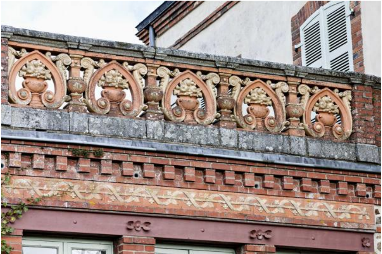
Détail du garde-corps du corps de logis bas.
