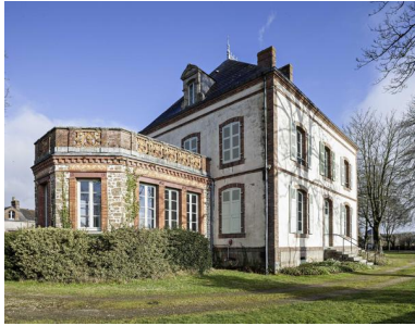
Maison, vue depuis le sud-est. Phot. Yves Guillotin IVR52_20225300014NUCA
