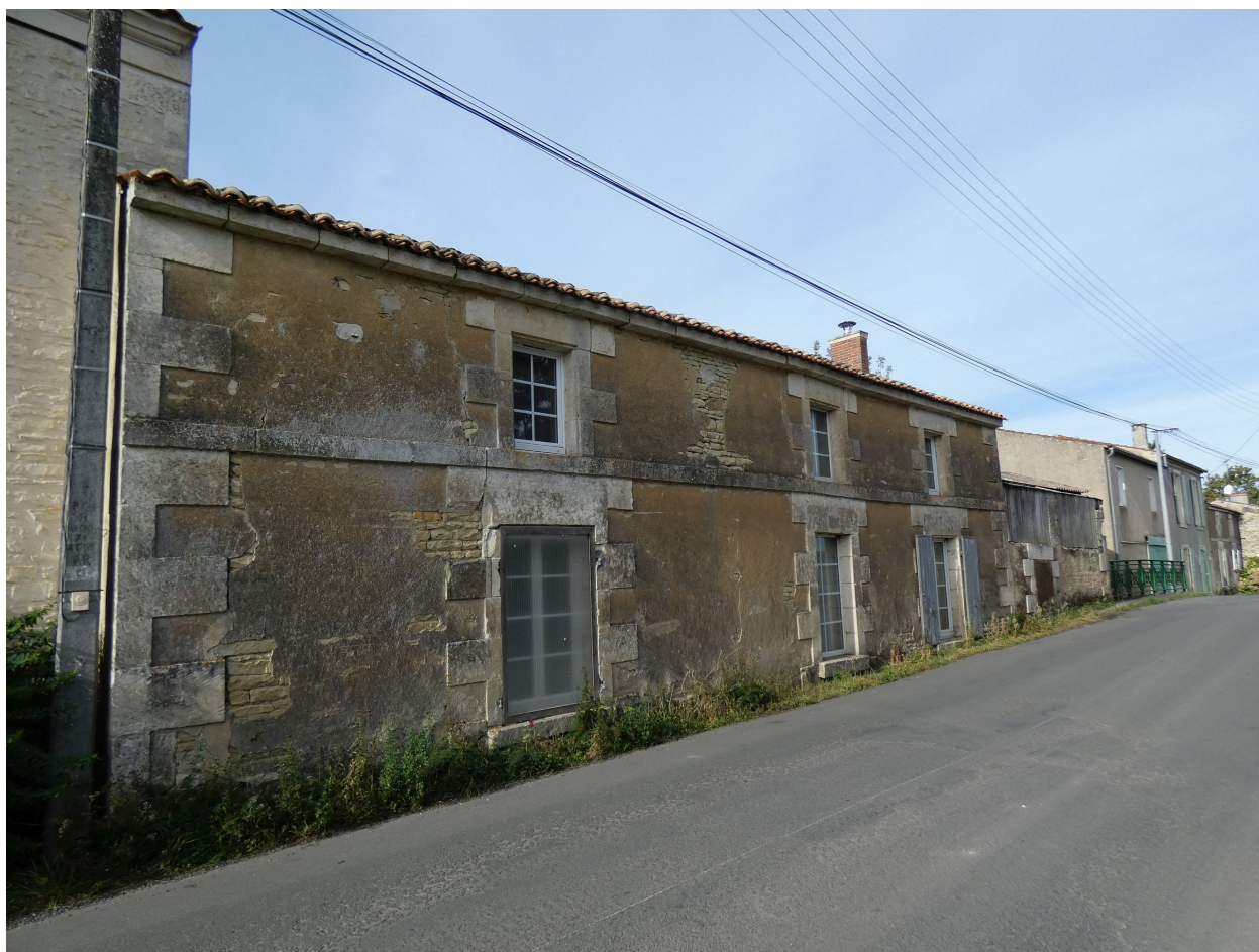
Le logis vu depuis l'est.
