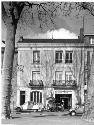
Elévation antérieure. Phot. François Lasa IVR52_19904900169V
