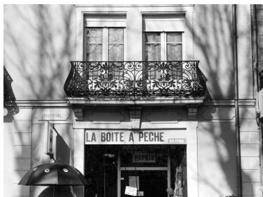
Elévation antérieure, 2e niveau : balcon de droite. Phot. François Lasa IVR52_19904900179X
