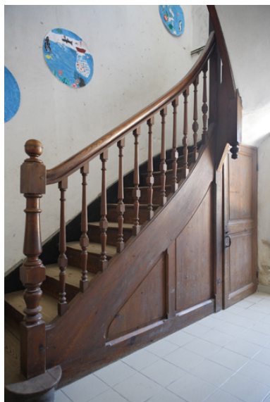
Vue de l'escalier. Phot. Denis Pillet IVR52_20084401860NUCA
