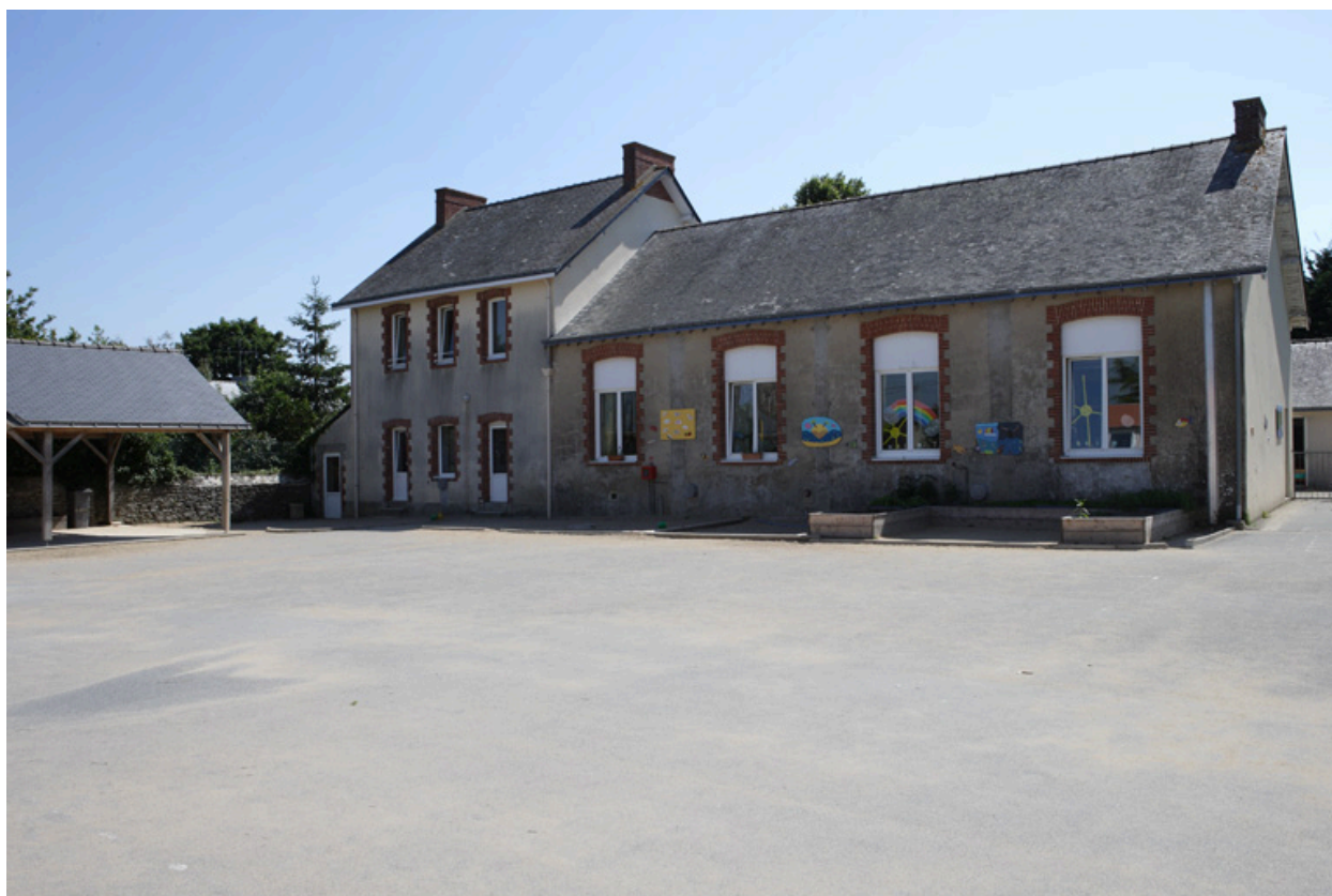
Vue de la façade arrière.
