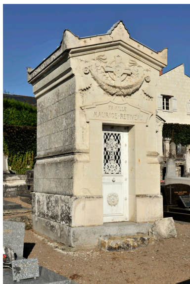
Chapelle funéraire de la famille Maurice-Rétiveau (vers 1885, signée sur oeuvre par Guignon, sculpteur à Saumur). Phot. Bruno Rousseau, Phot. Youenn Communeau IVR52_20114902712NUCA
