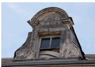
Maison, façade sur cour, comble : détail de la lucarne centrale. Phot. Jean-Baptiste Darrasse IVR52_20107201254NUCA
