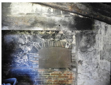
Le fournil. Phot. Yannis Suire IVR52_20188501210NUCA
