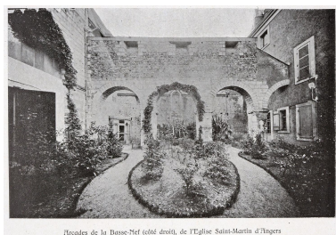
Arçades de la Basse-Nef (côté droit), de l'Eglise Saint-Martin d'Angers
