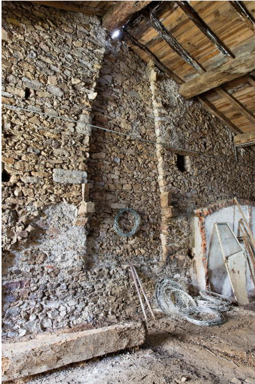
Vestiges d'un conduit de cheminée d'une maison en bordure du commun, HN-303, cadastre 2018.
