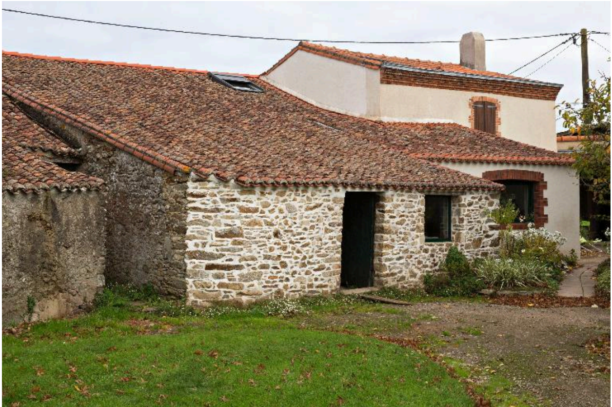
Habitations en bordure du commun, vue des façades arrière, HN-308, cadastre 2018.
