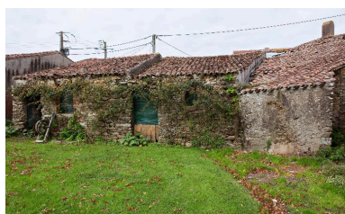
Habitations en bordure du commun, vue des façades arrière (3), HN-303, cadastre 2018. Phot. Denis Pillet IVR52_20154400523NUCA
