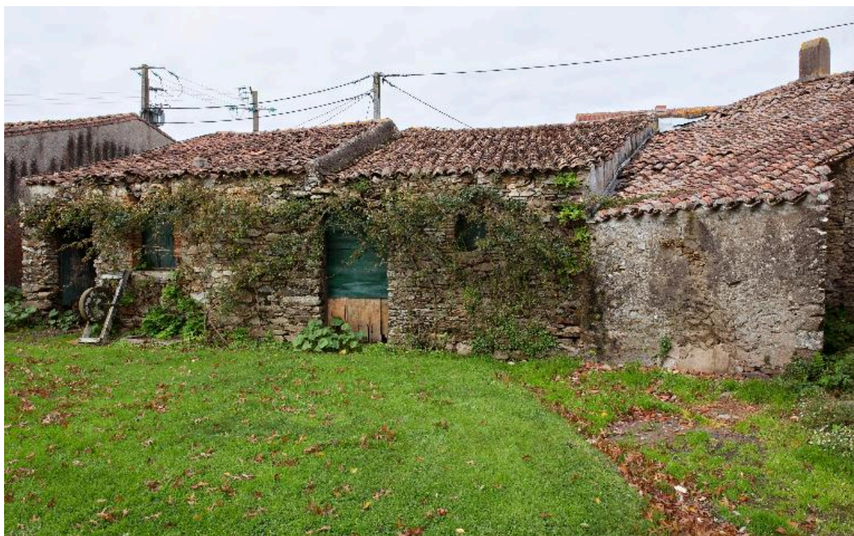
Habitations en bordure du commun, vue des façades arrière (3), HN-303, cadastre 2018.
