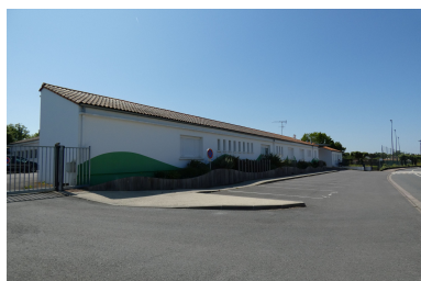
Le bâtiment administratif vu depuis le nord. Phot. Yannis Suire IVR52_20238501749NUCA
