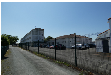
Le bâtiment technologique et le grand bâtiment de classes vus depuis le nord. Phot. Yannis Suire IVR52_20238501747NUCA
