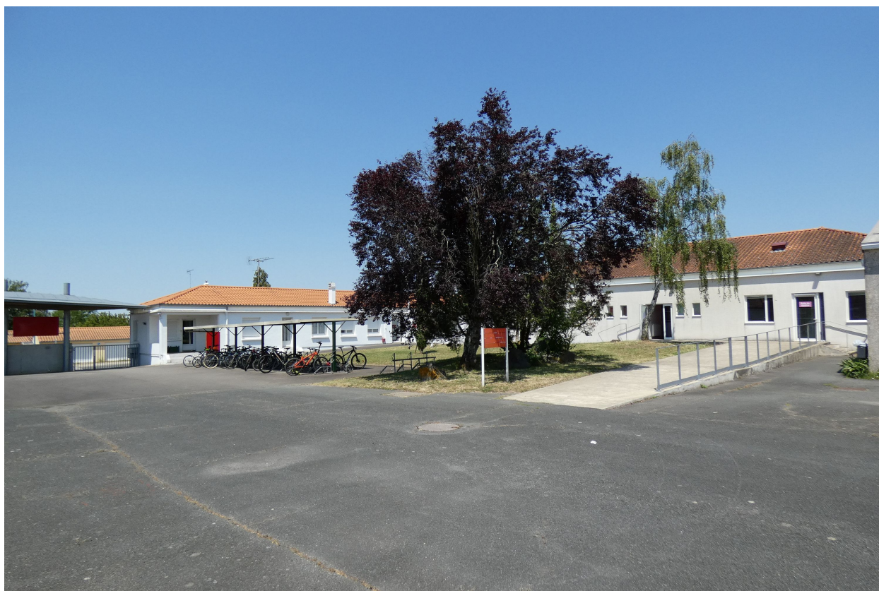
La première cour, l'entrée, le bâtiment administratif et le bâtiment technologique vus depuis le sud.
