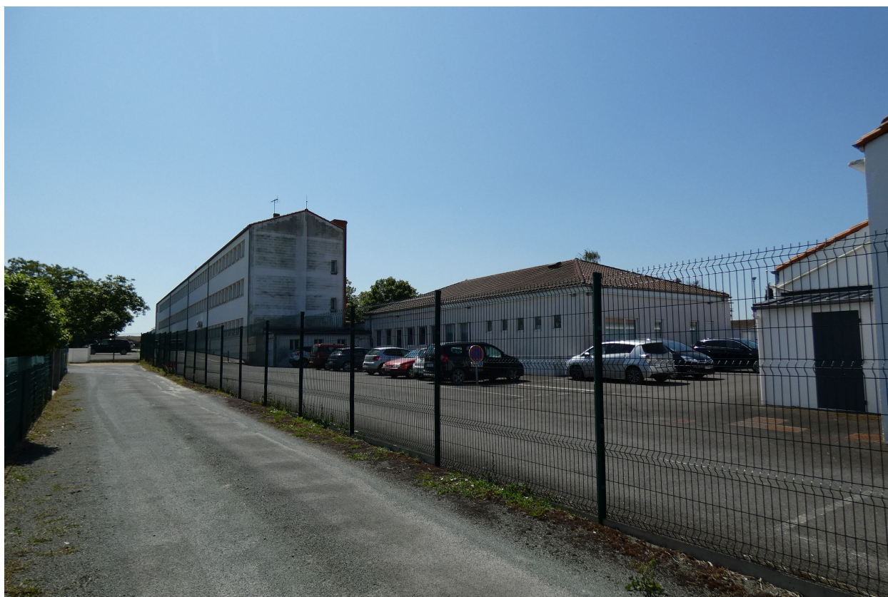
Le bâtiment technologique et le grand bâtiment de classes vus depuis le nord.
