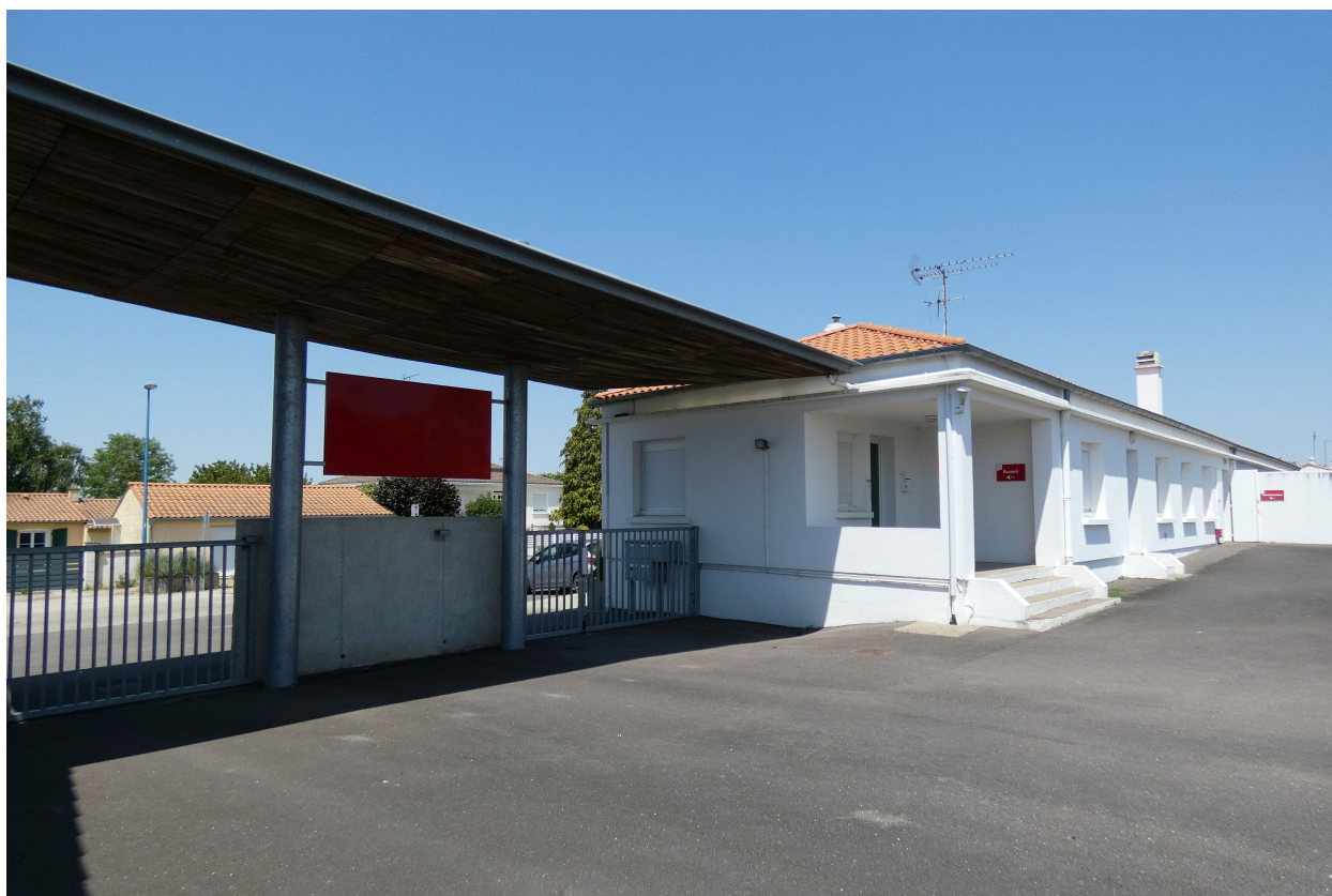
L'entrée et le bâtiment administratif vus depuis le sud.
