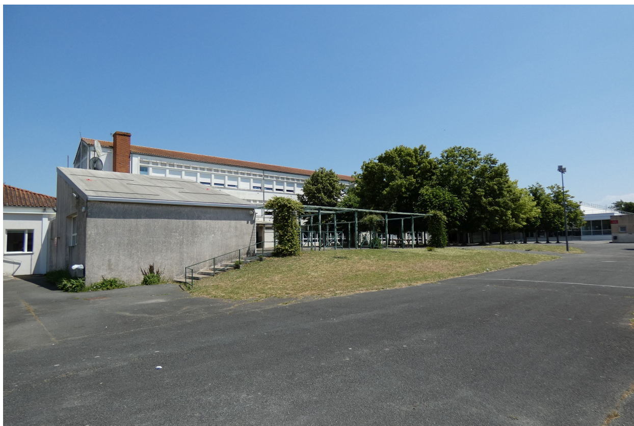
La seconde cour et le grand bâtiment de classes, vus depuis l'ouest.
