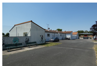
Les logements de fonction au sud de la première cour, vus depuis l'est. Phot. Yannis Suire IVR52_20238501884NUCA
