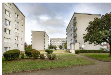
Vue des immeubles collectifs avenue du Maine. Phot. Pierre-Bernard Fourny IVR52_20197202597NUCA
