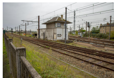
Vue d'un pavillon d'aiguillage de la gare de triage. Phot. Pierre-Bernard Fourny IVR52_20197202541NUCA
