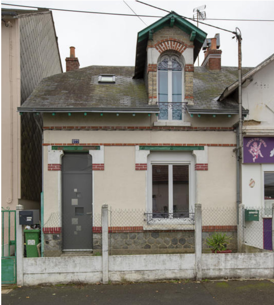
Vue d'une maison construite en 1900 rue Jean-Jacques-Rousseau.
