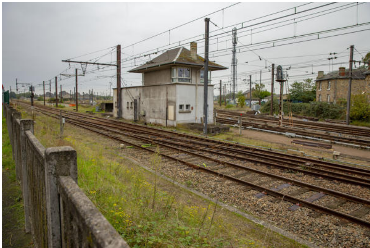
Vue d'un pavillon d'aiguillage de la gare de triage.
