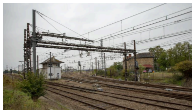
Vue de la gare de triage. Phot. Pierre-Bernard Fourny IVR52_20197202540NUCA
