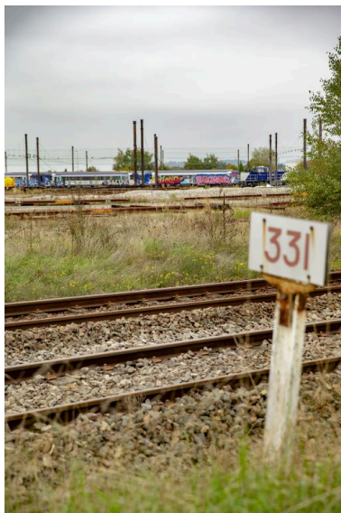
Vue des voies bordant la cité cheminote. Phot. Pierre-Bernard Fourny IVR52_20197202560NUCA
