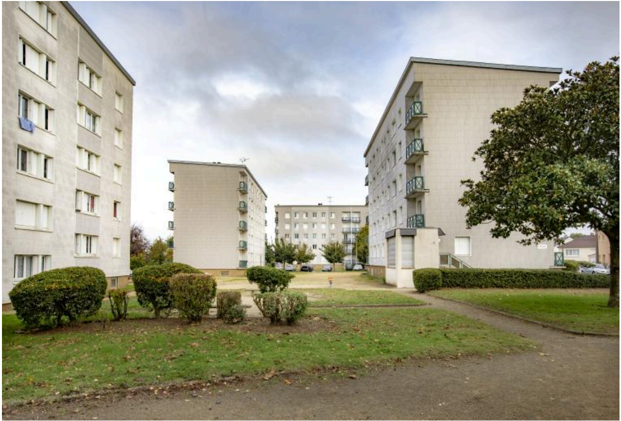
Vue des immeubles collectifs avenue du Maine.
