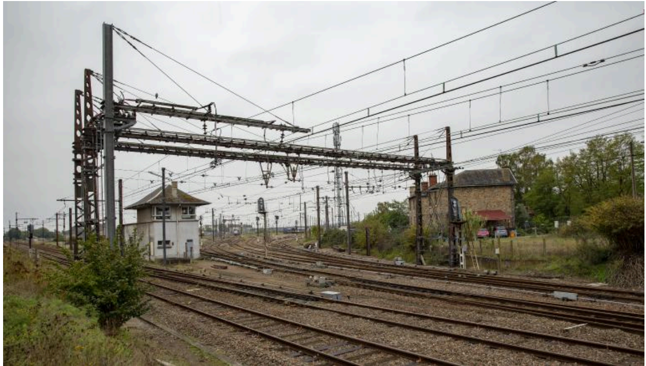
Vue de la gare de triage.
