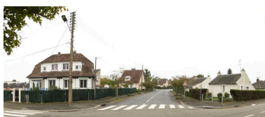
Vue de l'avenue Pierre-Semard. Phot. Pierre-Bernard Fourny IVR52_20197202562NUCA
