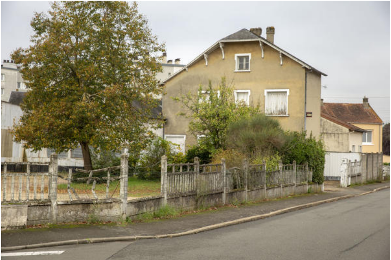
Vue d'une maison années 1910 rue du Maroc.
