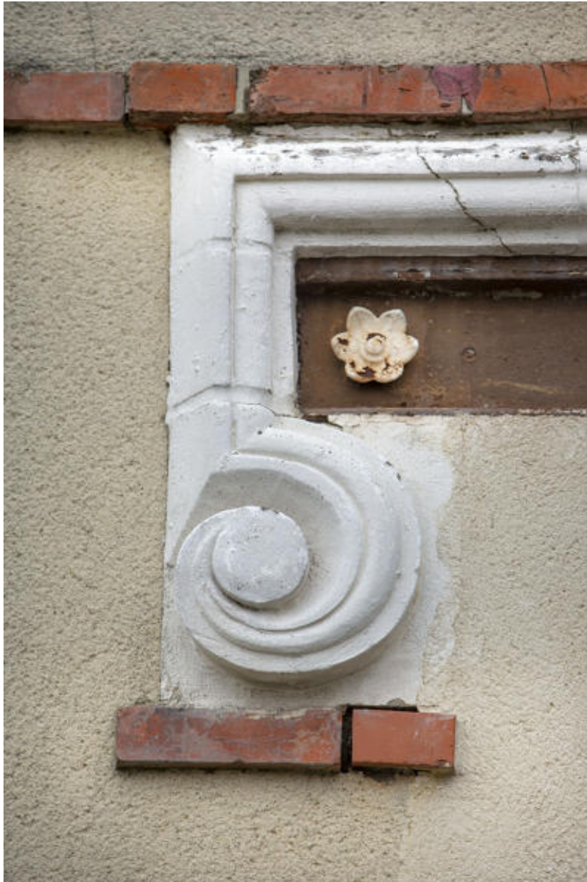
Détail d'un linteau métallique rue du Docteur-Dugué.
