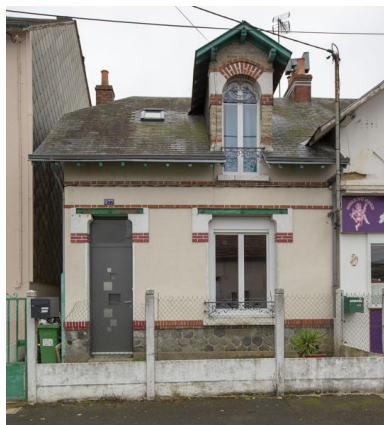
Vue d'une maison construite en 1900 rue Jean-Jacques-Rousseau. Phot. Pierre-Bernard Fourny IVR52_20197202557NUCA
