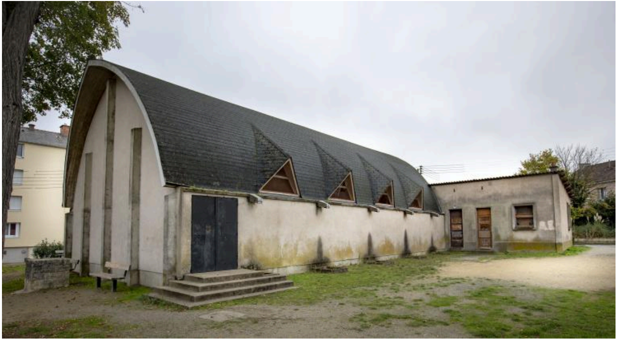
Vue de la chapelle de la Sainte-Famille depuis l'ouest.
