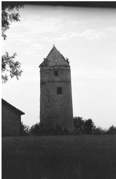
Vue générale du moulin-tour de Rohou de Saint-Laurent-du-Mottay. Phot. Marie-Anne Eon IVR52_19724900543Z
