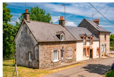
Ecart du Pont de Couterne, maisons (ZE 136-141). Phot. Pierre-Bernard Fourny IVR52_20235300858NUCA
