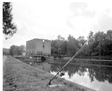
Vue prise de l'amont de l'écluse, du moulin (façades est et nord) et de la centrale hydroélectrique. Phot. François Lasa IVR52_20015300468X
